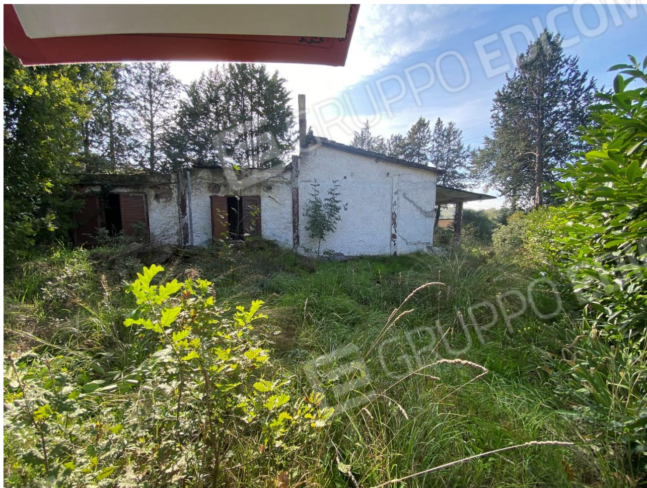
3. Prospetto lato Nord
