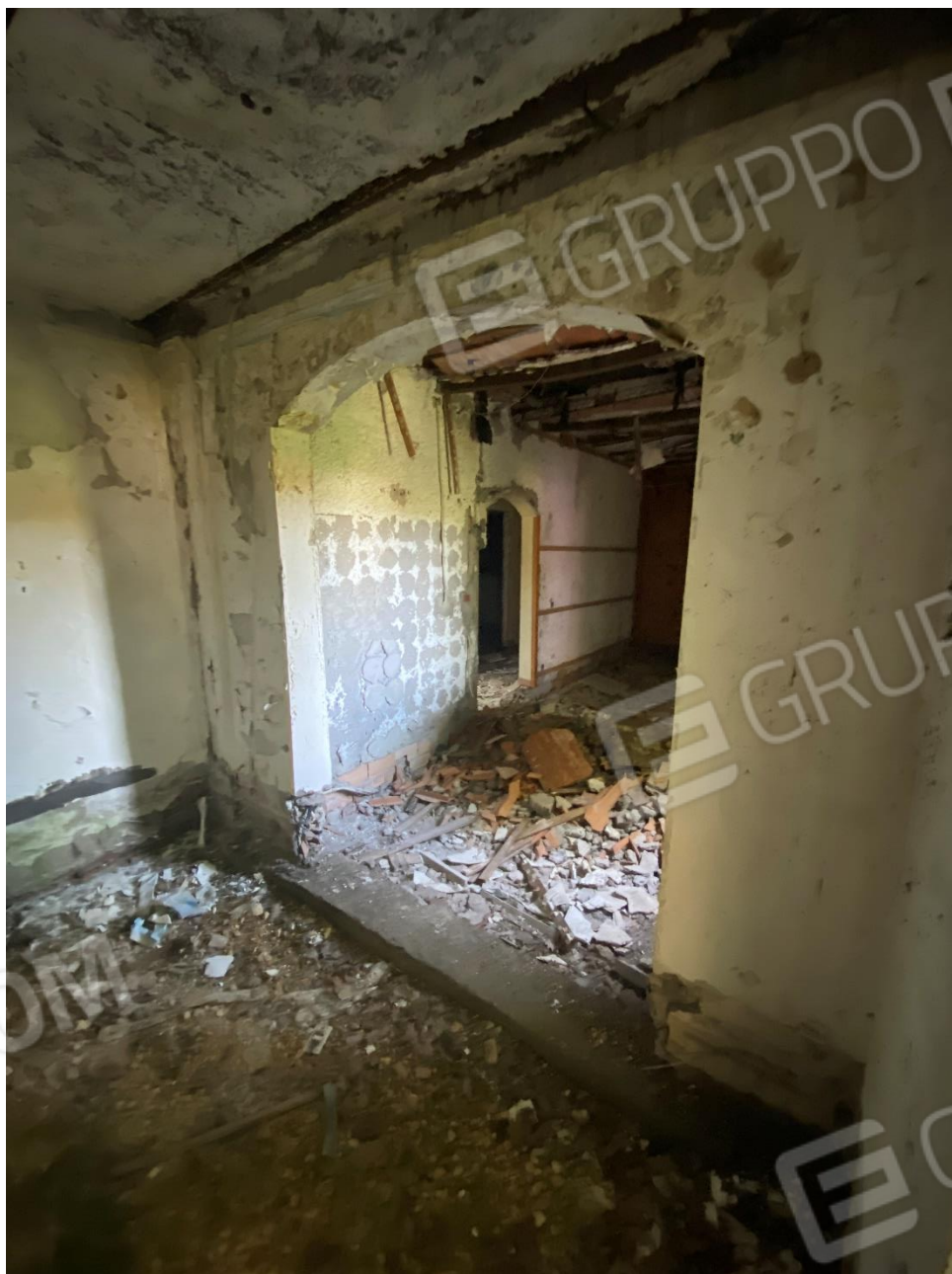
2. Foto interne in evidenza i lavori di smantellamento di pavimenti e maioliche cucina
