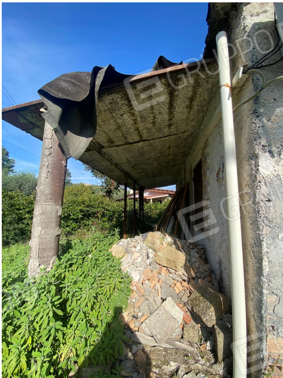
4. Zona Portico con materiali di risulta accantonati
