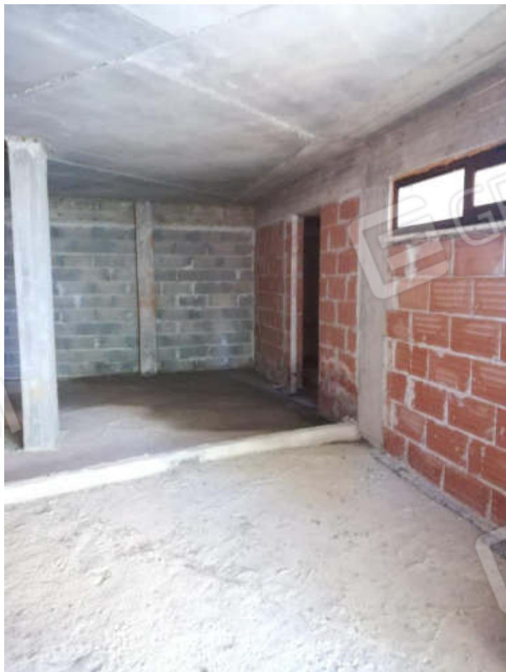
Foto 50 e 51 - Vista interna garage , piano S1
