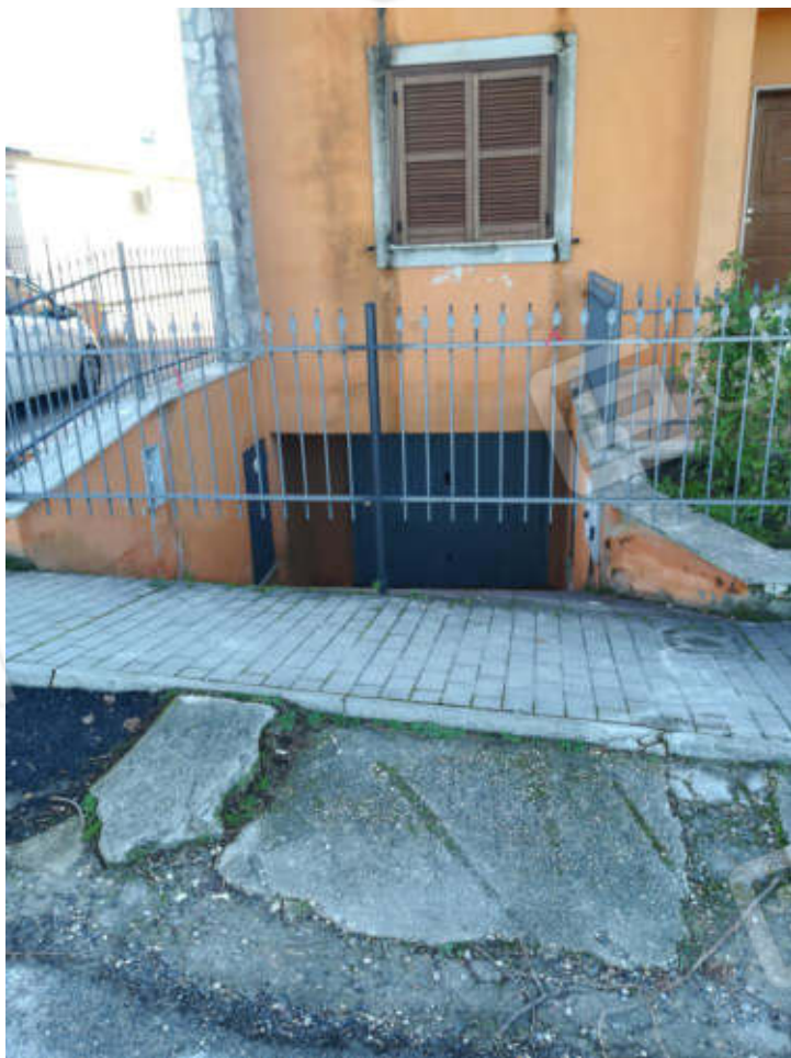
Foto 16 e 17 – Lotto n. 1 - Vista garage
