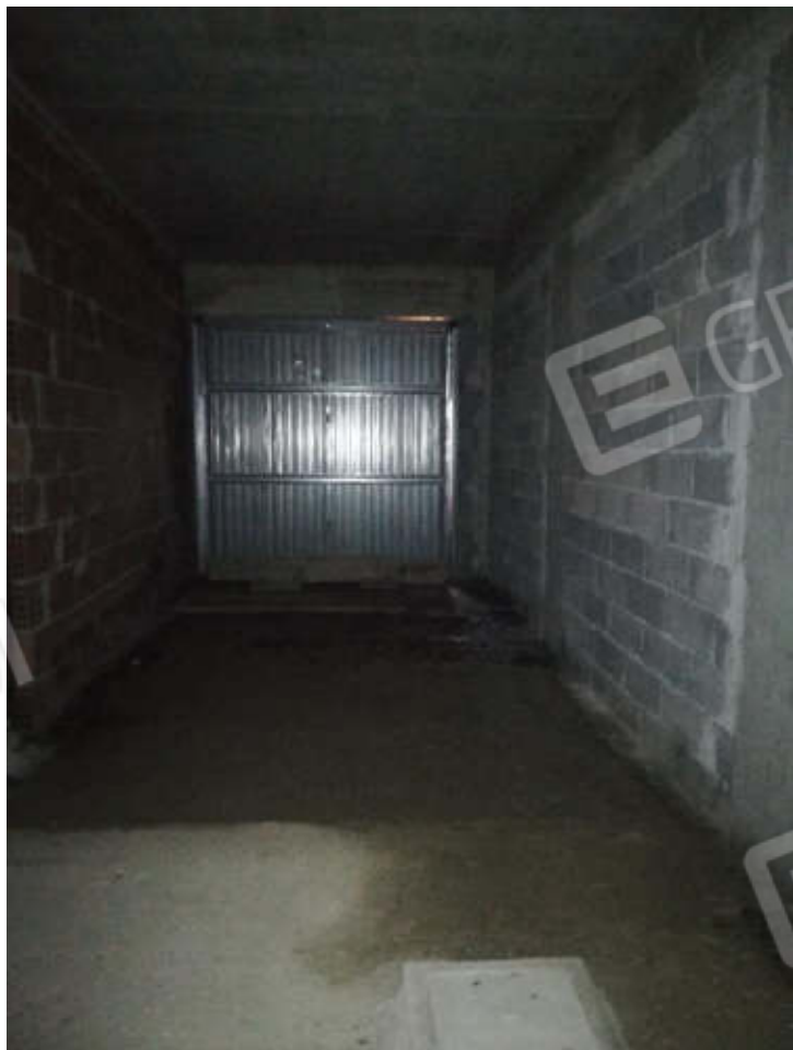
Foto 29 e 30 - Vista interna garage, piano S1
