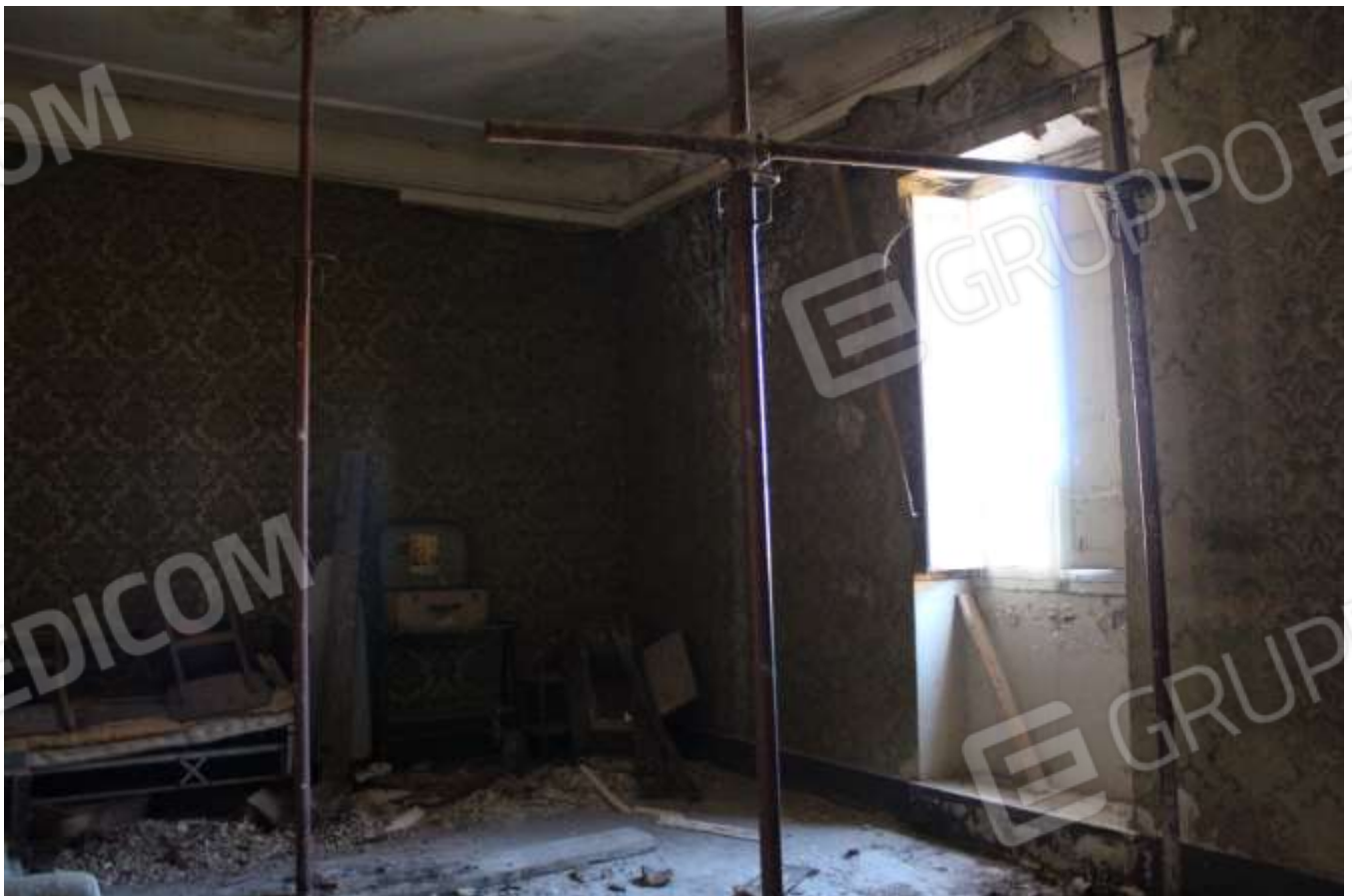
Foto 06 – Camera 1 (Piano Primo)
