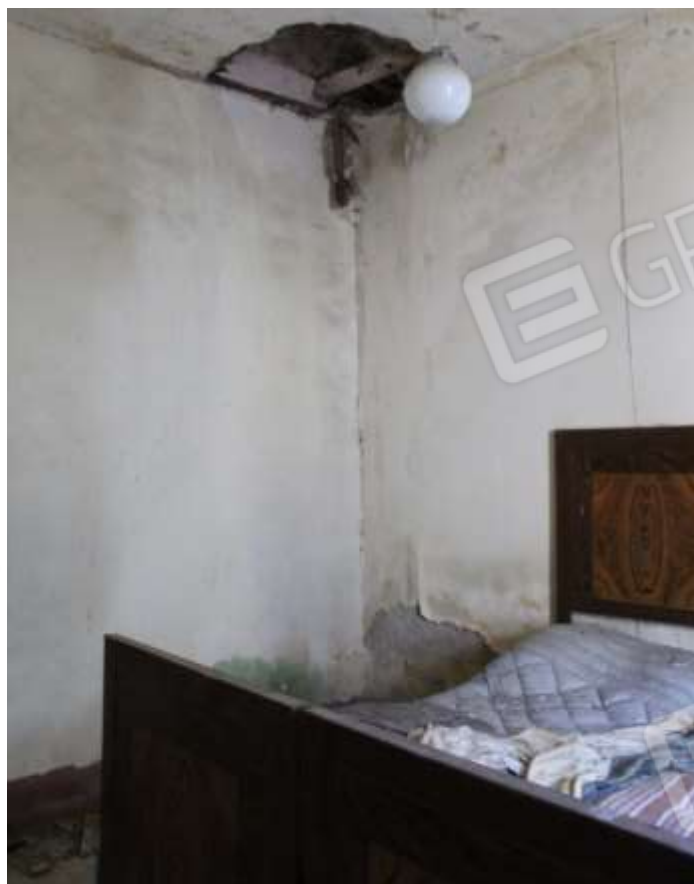
Foto 08 – Camera 3 (Piano Primo)
