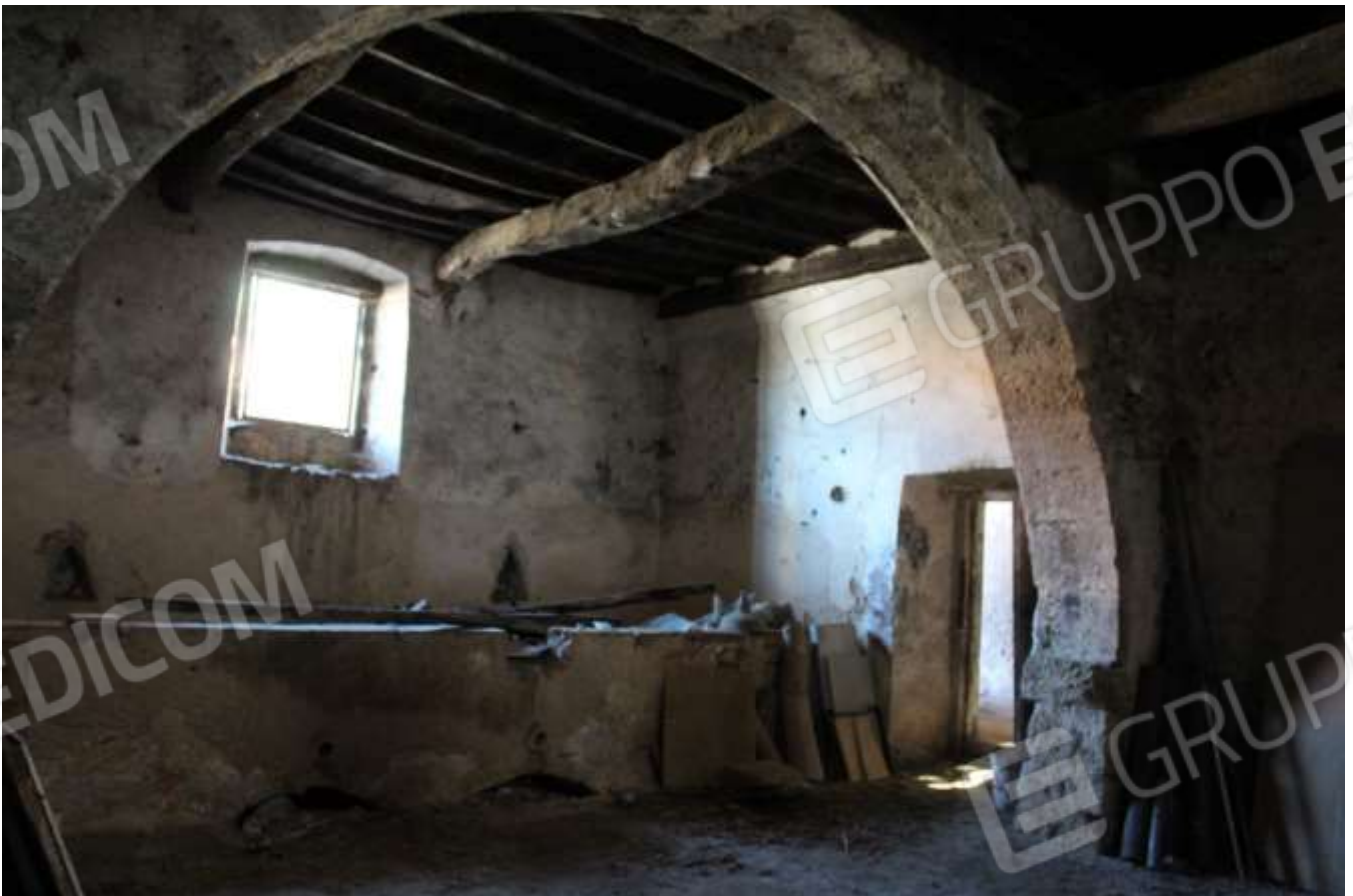
Foto 04 – Deposito 1 (Piano Terra)
