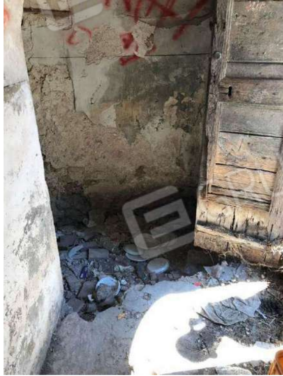
Foto 1 – Ingresso vano scala
