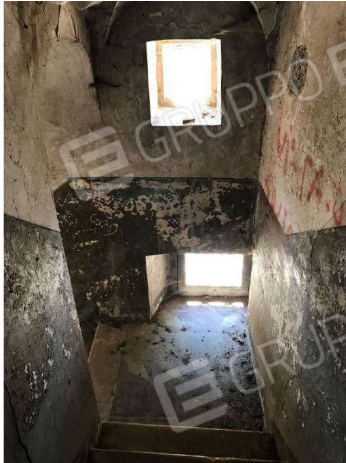
Foto 7 – Ingresso vano scala
