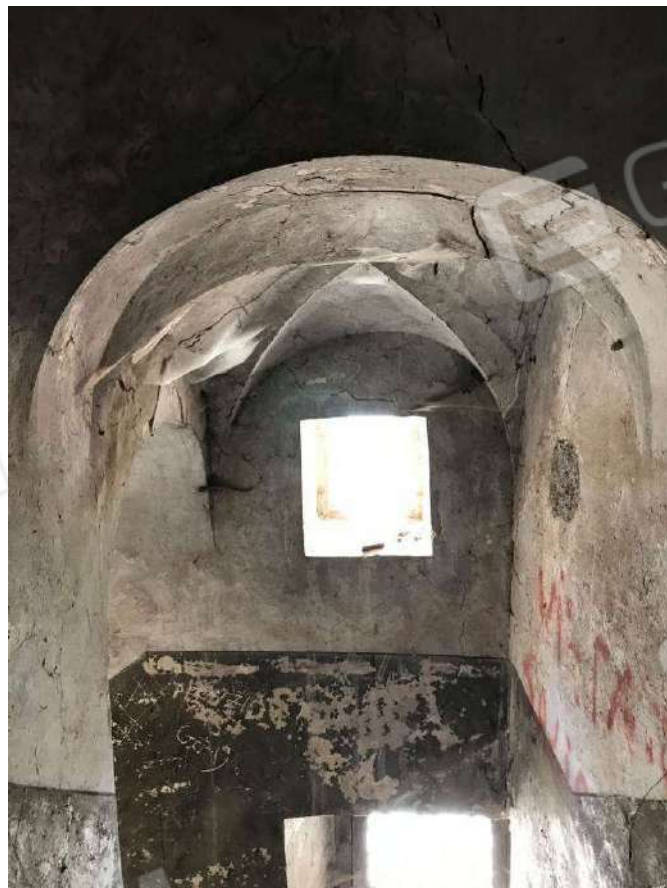
Foto 8 – Ingresso vano scala
