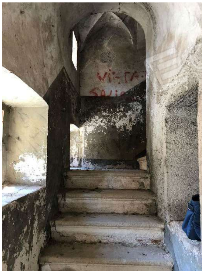
Foto 4 – Ingresso vano scala
