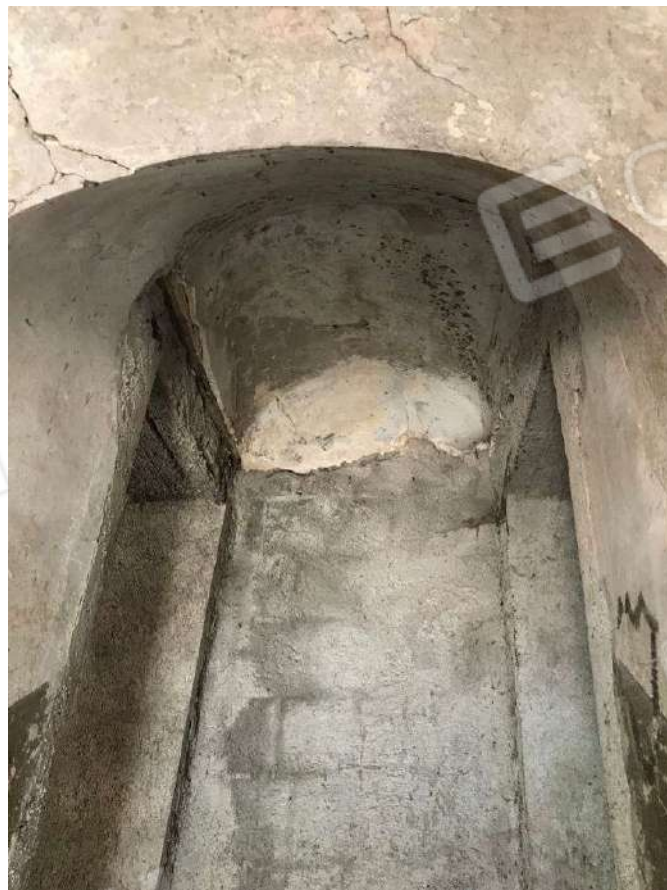
Foto 6 – Ingresso vano scala
