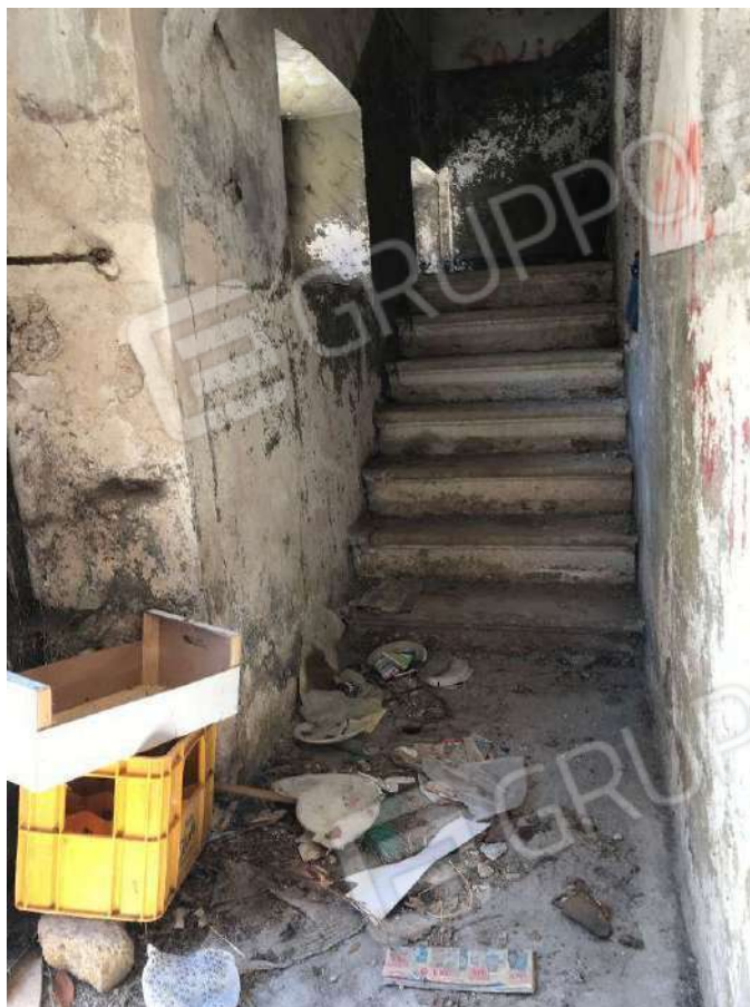
Foto 3 – Ingresso vano scala
