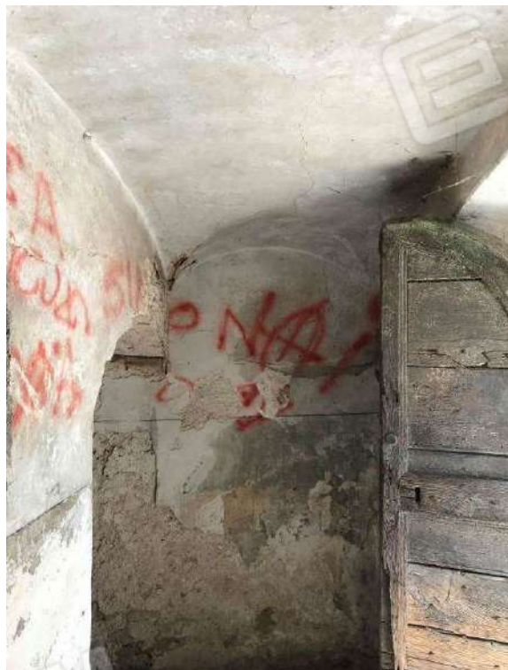
Foto 2 – Ingresso vano scala
