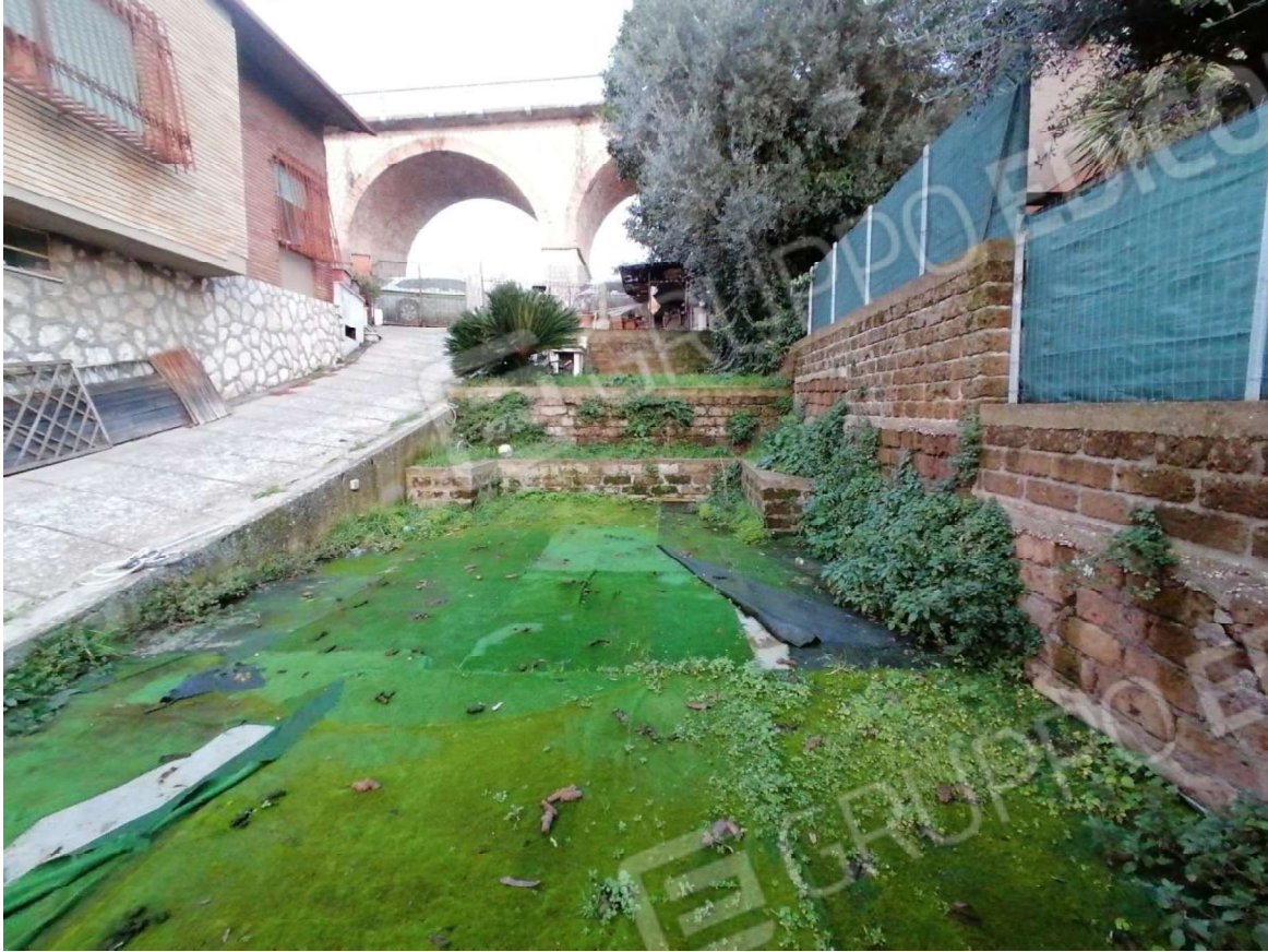
FOTO N°39 Corte esterna – particolare relativo alla parte terrazzata.
