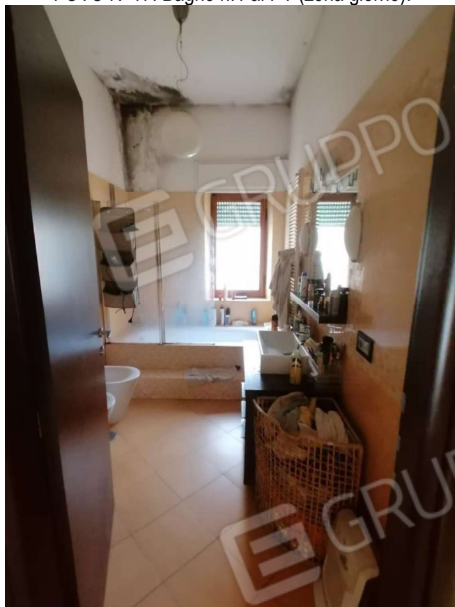
FOTO N°17: Bagno n.1 al PT (zona giorno).
