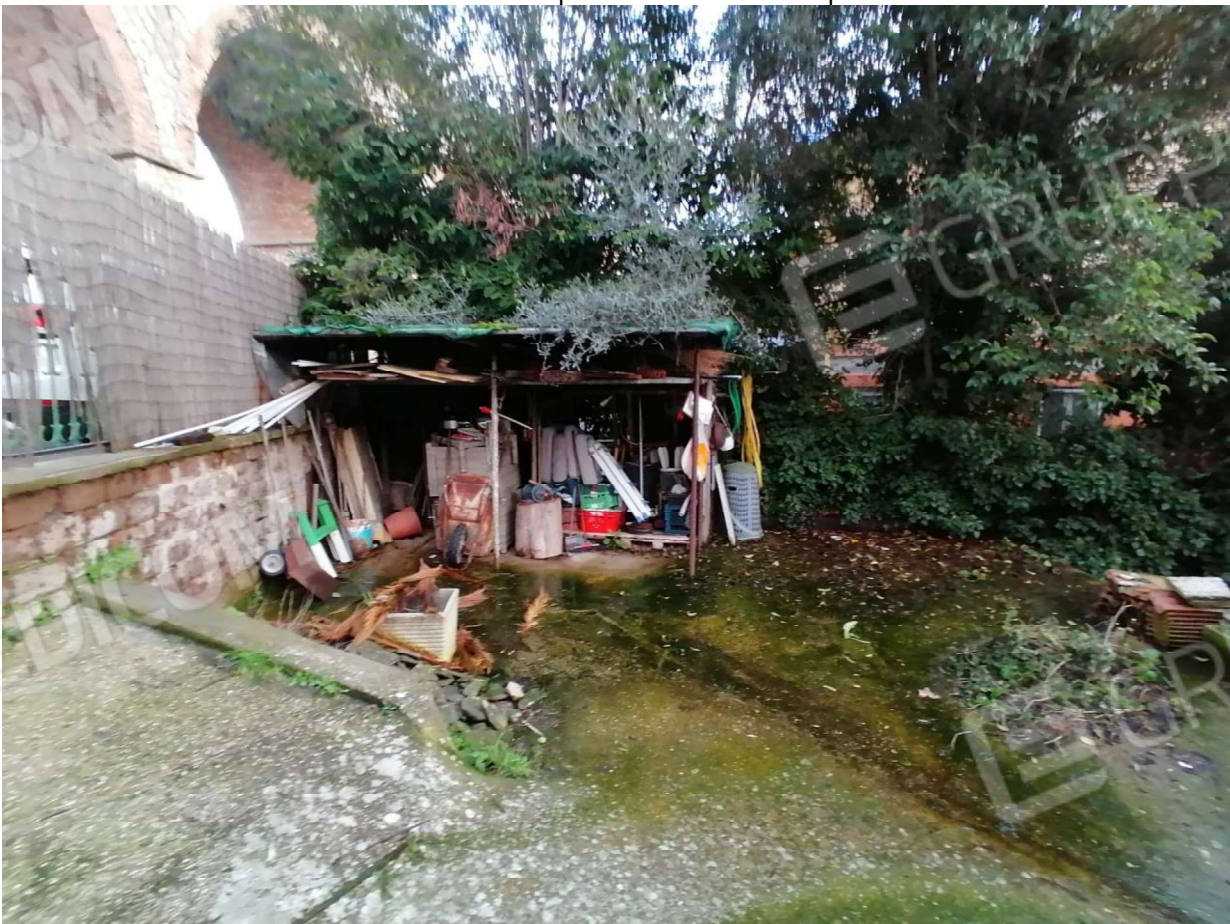
FOTO N°40: Corte esterna – particolare relativo alla parte terrazzata.
