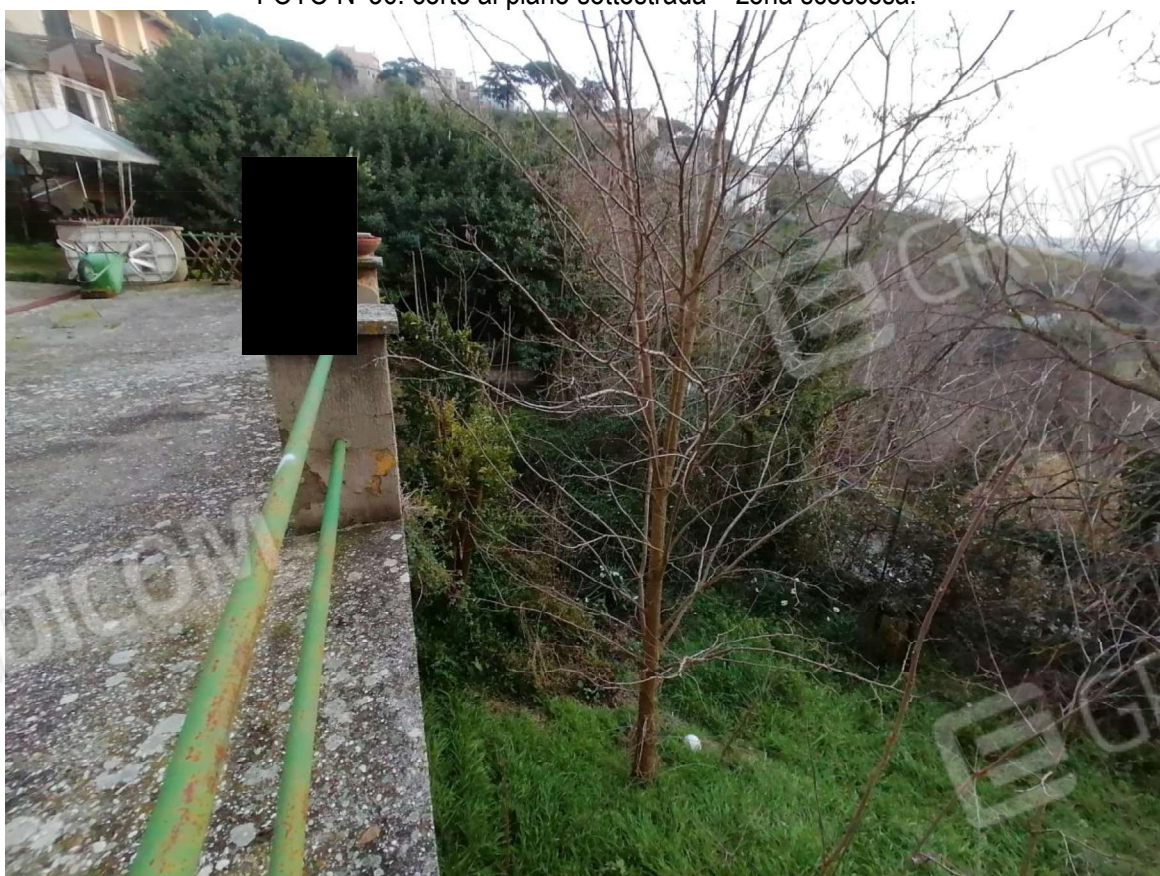
FOTO N°36: corte al piano sottostrada – zona scoscesa.
