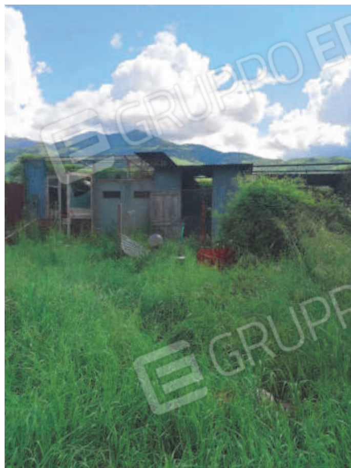
Foto 12 – Viste esterne manufatti presenti sulla corte esterna
