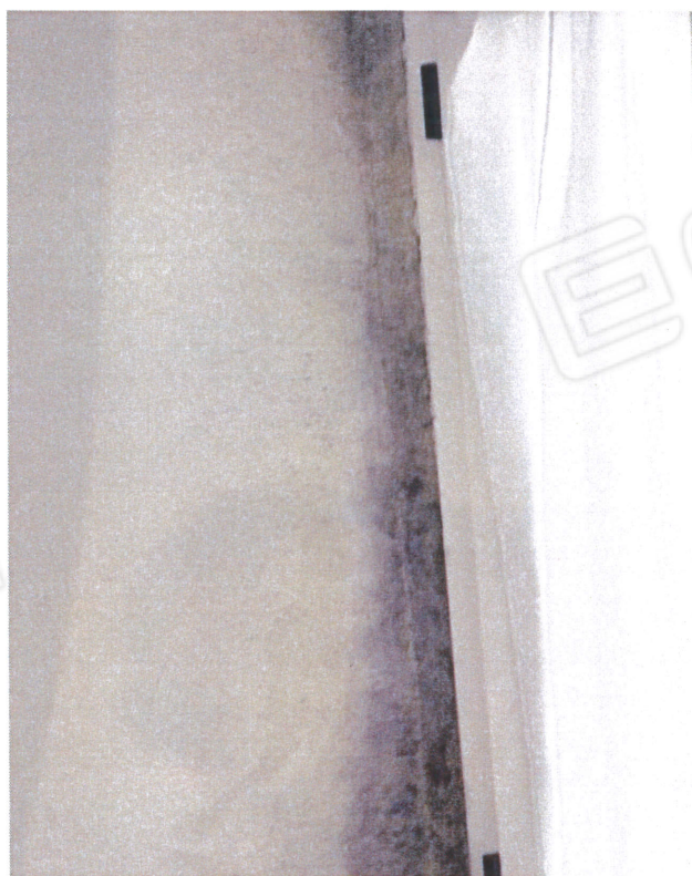
Particolare macchie di condensa agli angoli delle finestre
