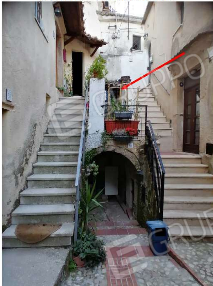
FOTO N°03: Zona di accesso alla U.I.
