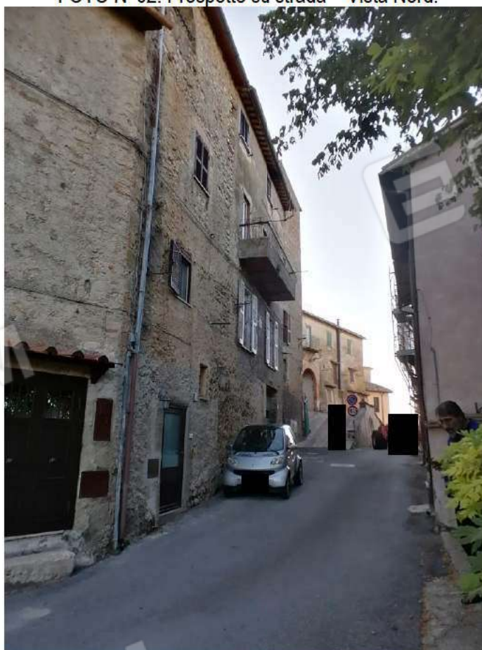
FOTO N°02: Prospetto su strada – Vista Nord.
