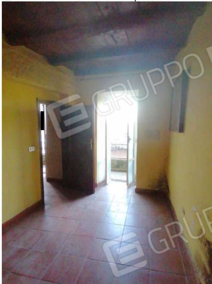
FOTO N°11: Camera U.I. – vista verso portafinestra su balcone.
