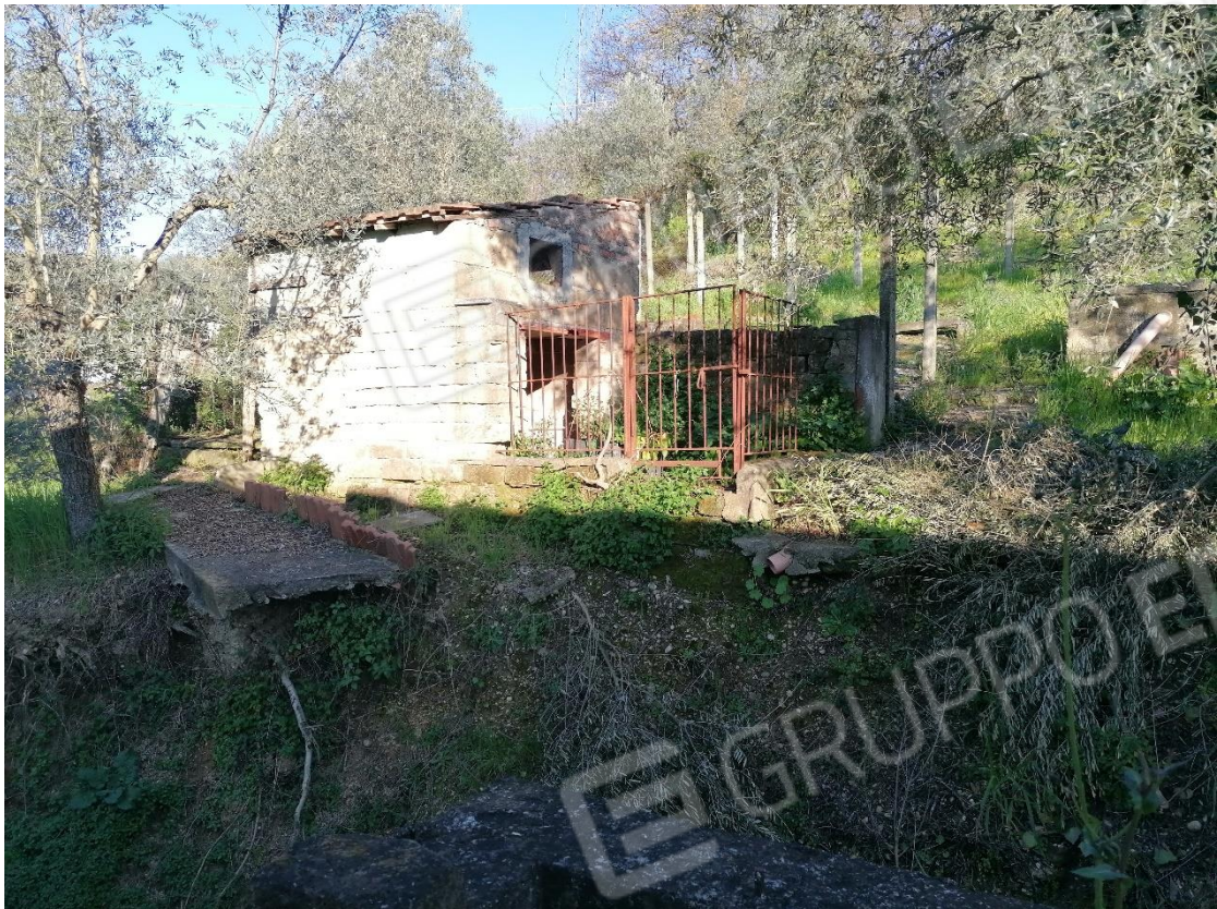
Foto 05: Accessorio su corte esterna esclusiva - Ripostiglio esterno.
