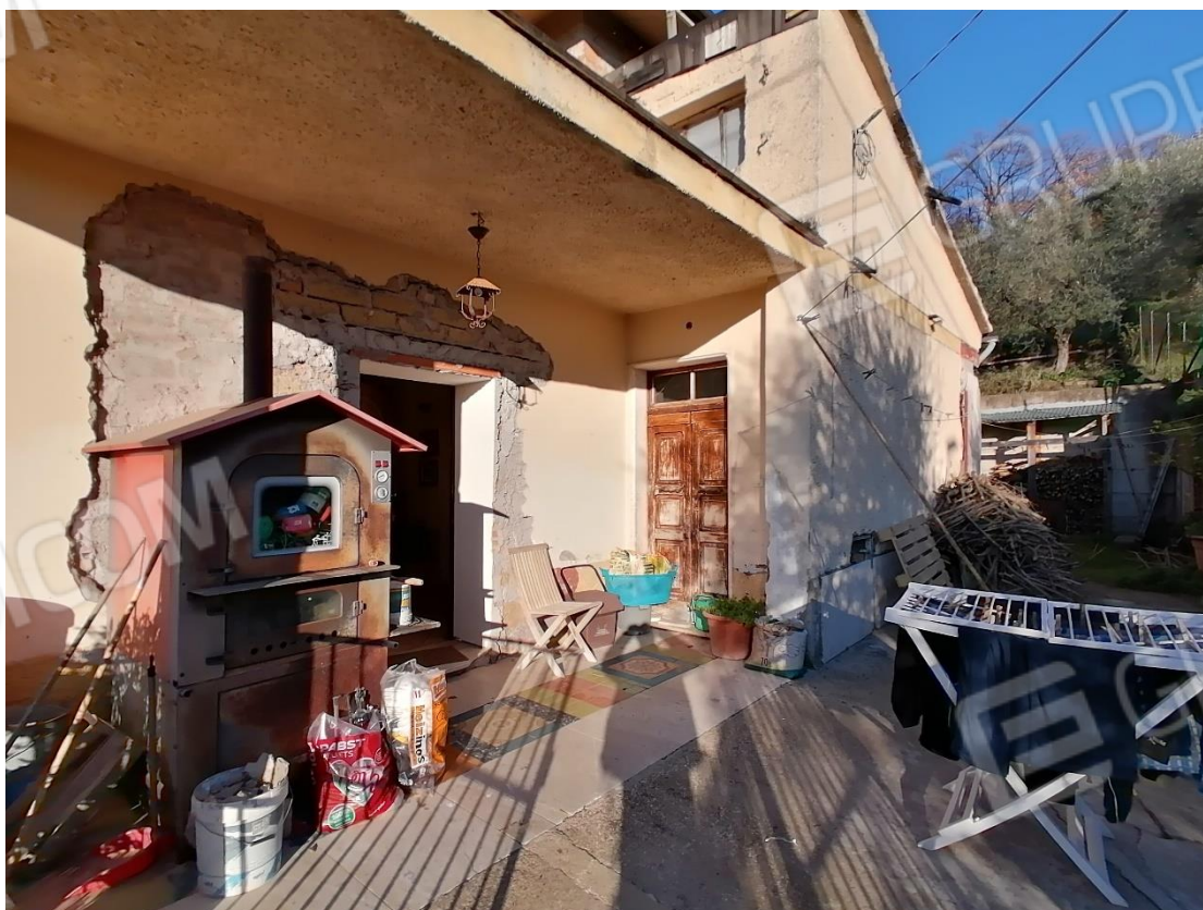
Foto 02: Prospetto Sud - Ingresso principale al fabbricato.
