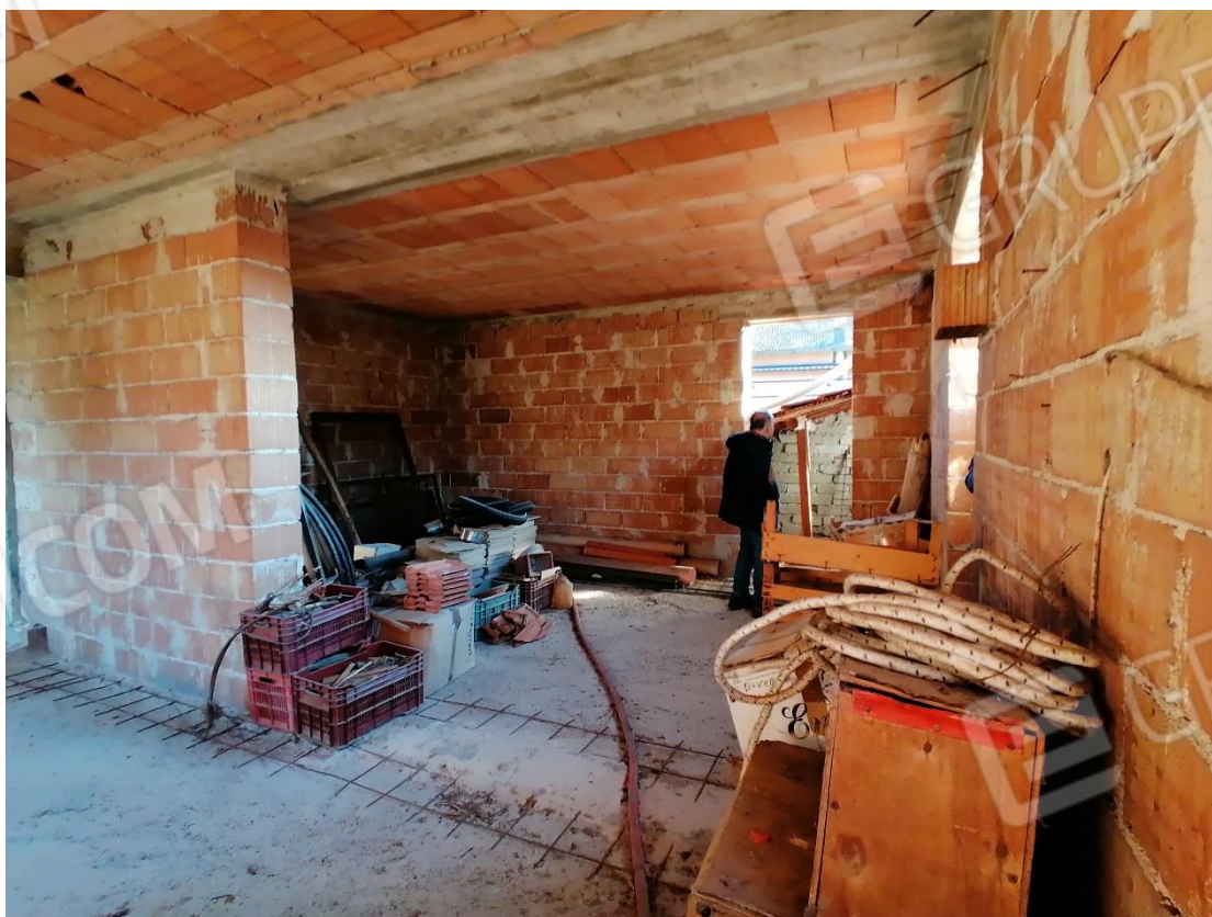
Foto 31: Interno u.i. Piano Primo – Locali al rustico.
