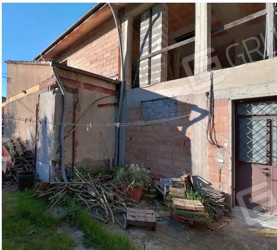
Foto 04: Prospetto Sud - Ingresso secondario al garage.
