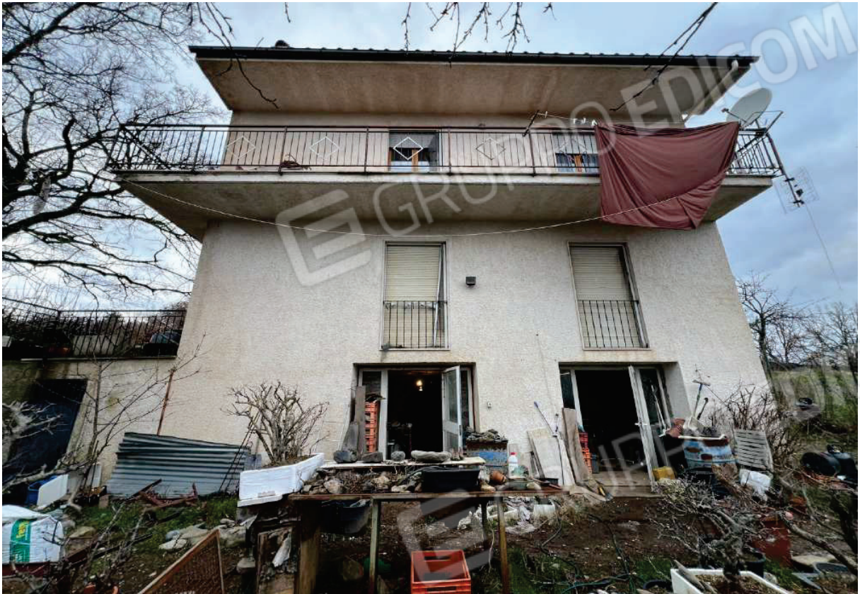
FOTO 3: Veduta esterna prospetto nord-est
