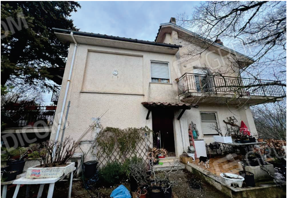
FOTO 2: Veduta esterna prospetto sud-est
