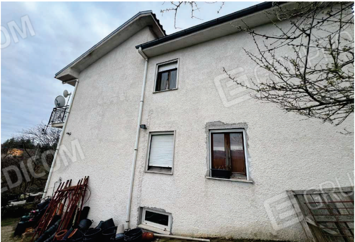
FOTO 4: Veduta esterna prospetto nord-ovest
