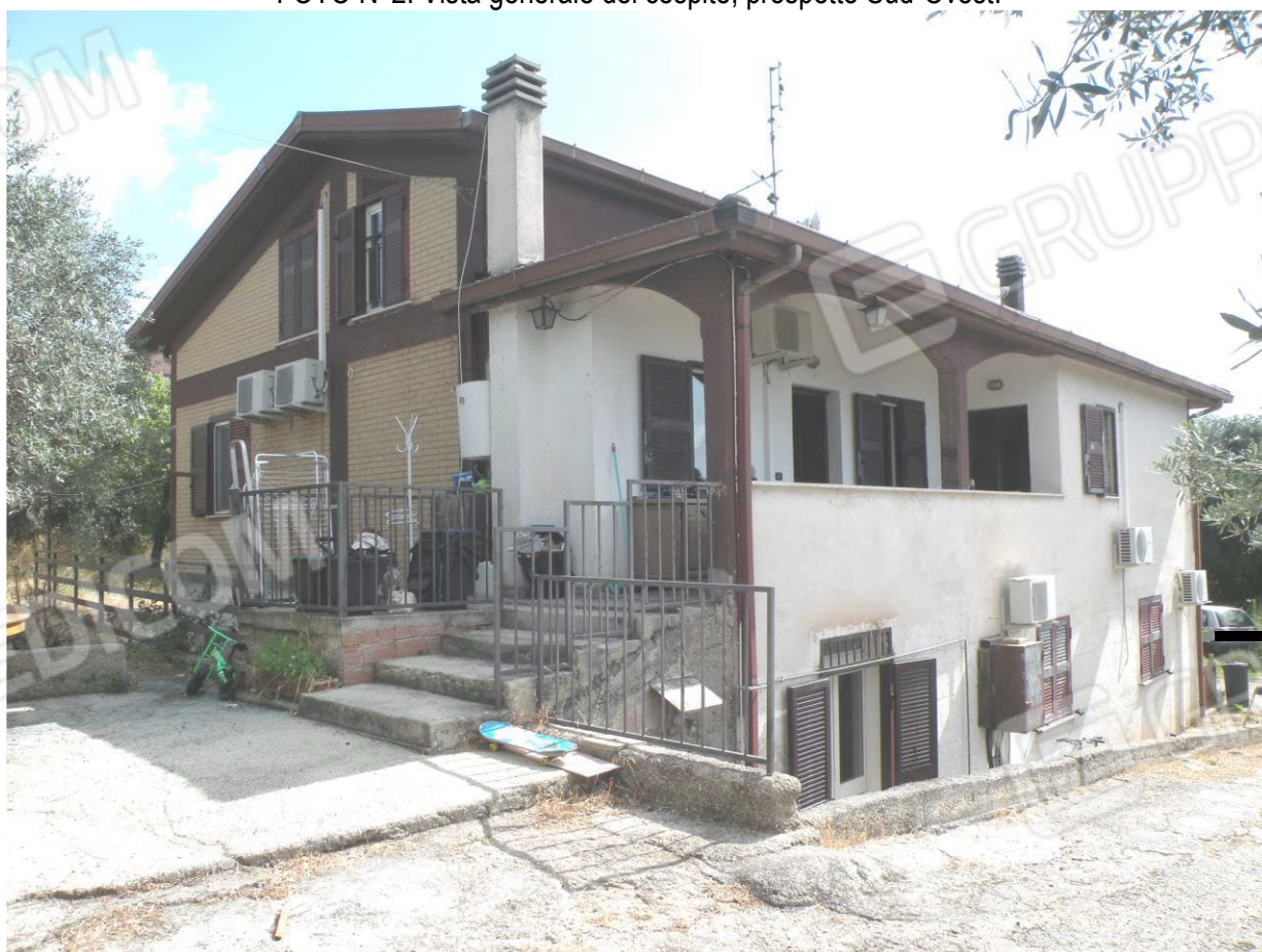
FOTO N°2: Vista generale del cespite, prospetto Sud-Ovest.
