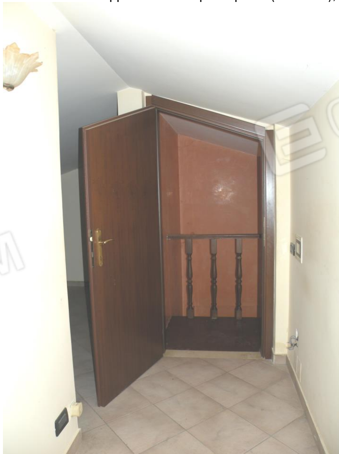
FOTO N°41: Vista interna dell'appartamento al piano primo (sottotetto), disimpegno/2.
