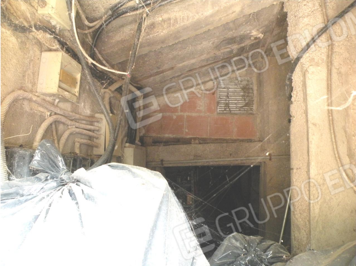
FOTO N°30: Vista interna dell'intercapedine al piano seminterrato.
