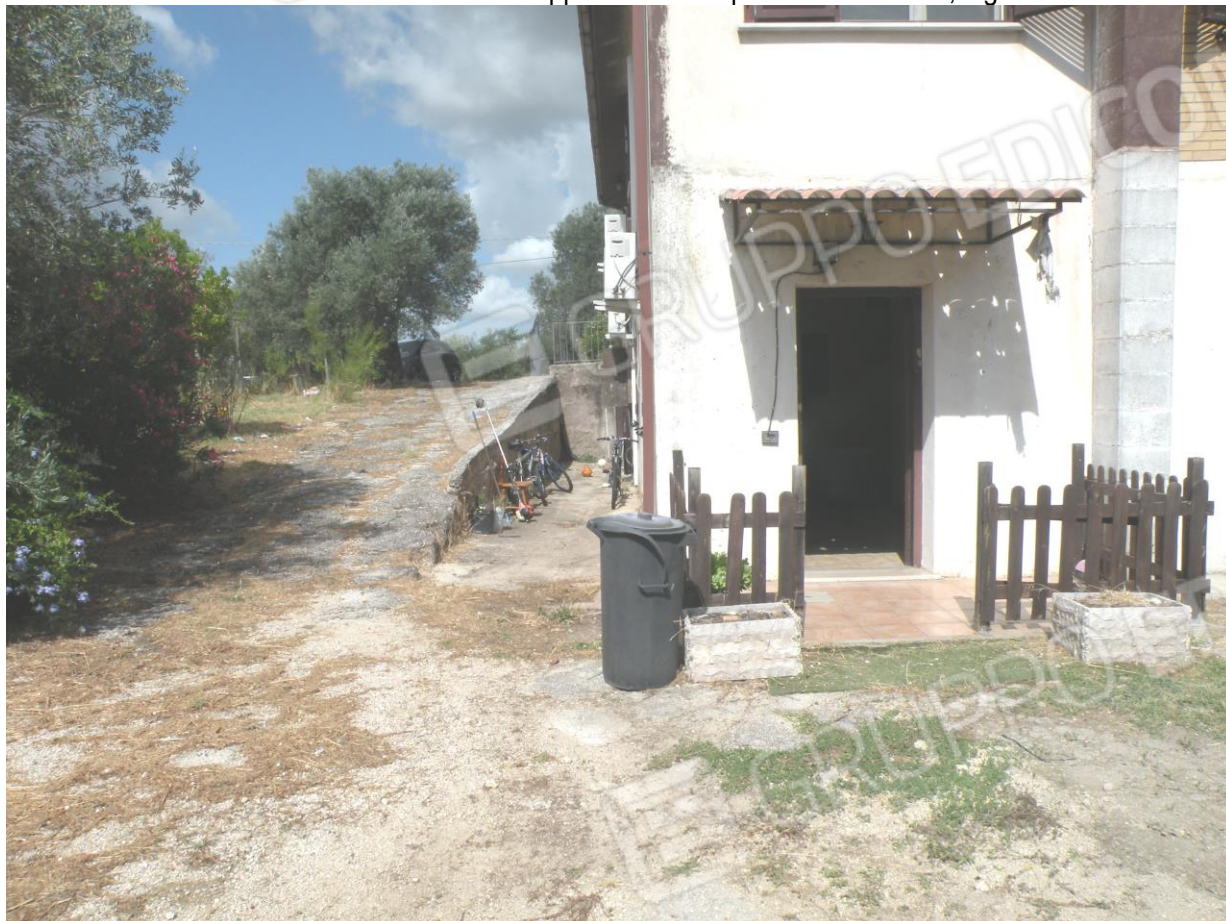
FOTO N°13: Vista esterna dell'appartamento al piano seminterrato, ingresso.
