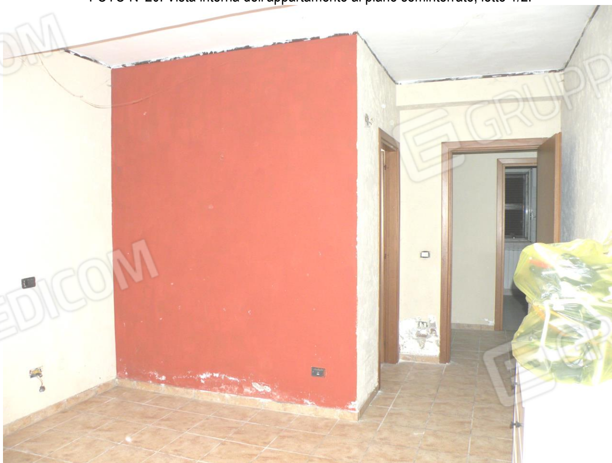
FOTO N°20: Vista interna dell'appartamento al piano seminterrato, letto 1/2.
