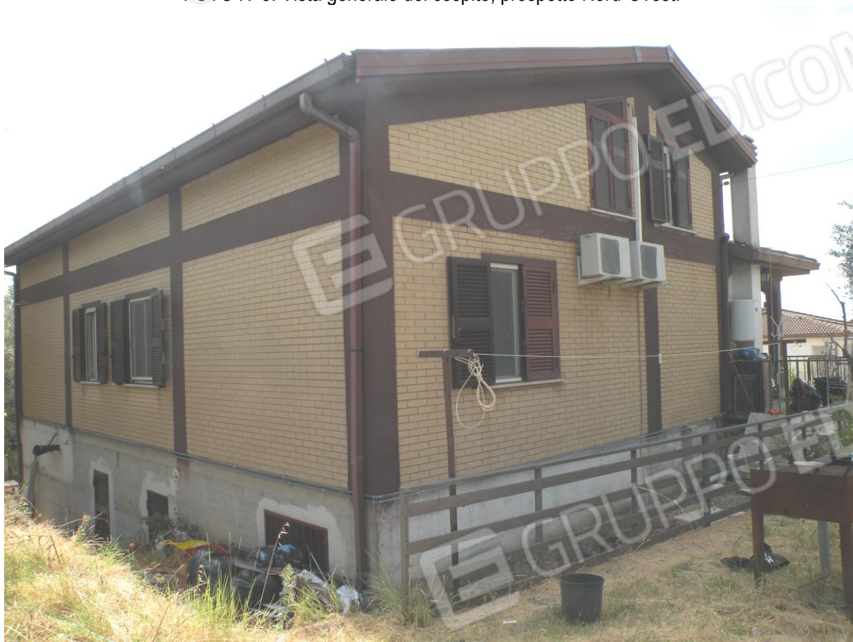
FOTO N°3: Vista generale del cespite, prospetto Nord-Ovest.
