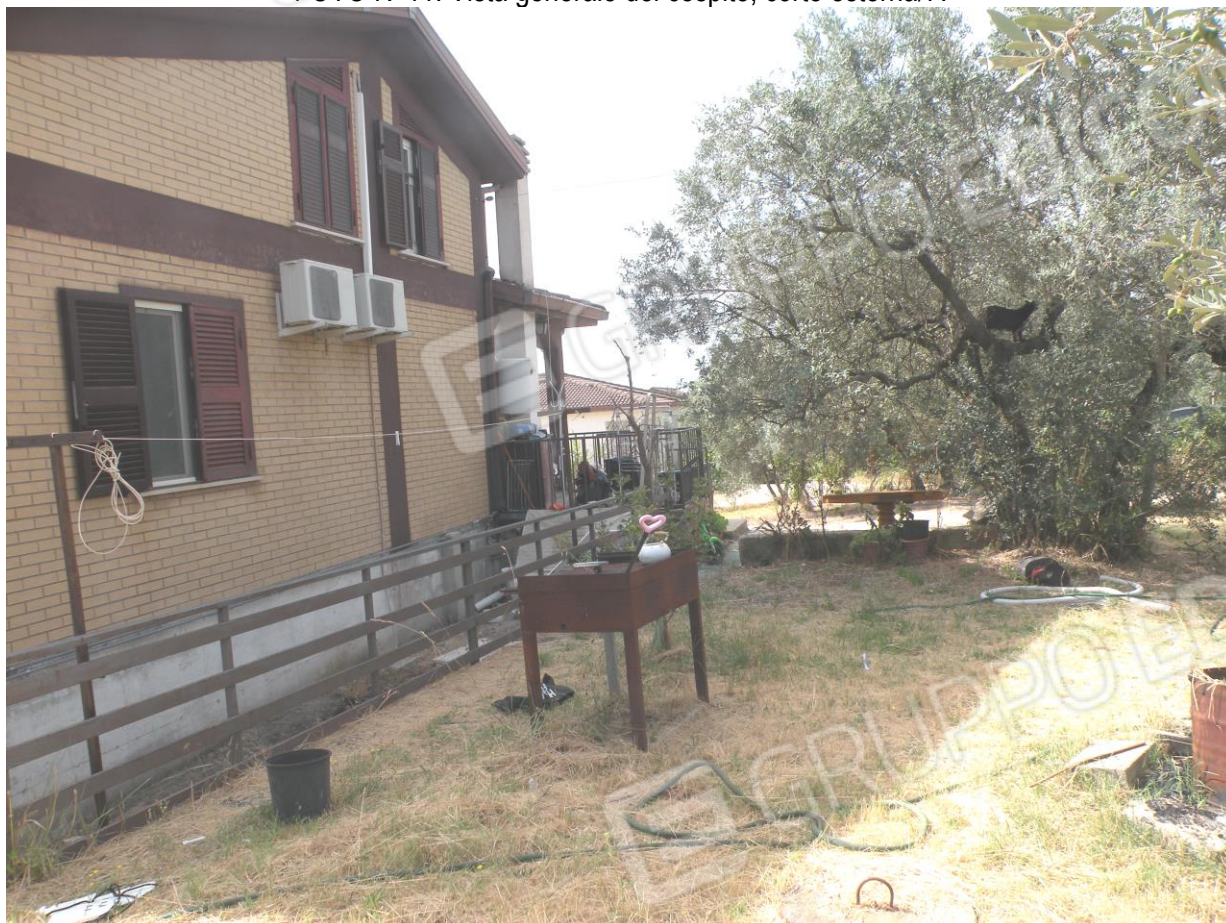
FOTO N°11: Vista generale del cespite, corte esterna/7.
