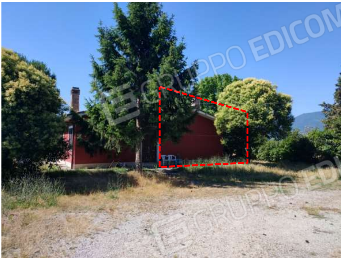
FOTO 1 – Esterno Lato Nord ( Sub. 1)
