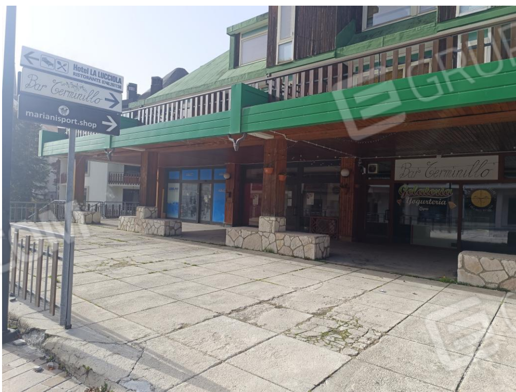
Foto n. 2 – Prospetto area porticata di accesso
