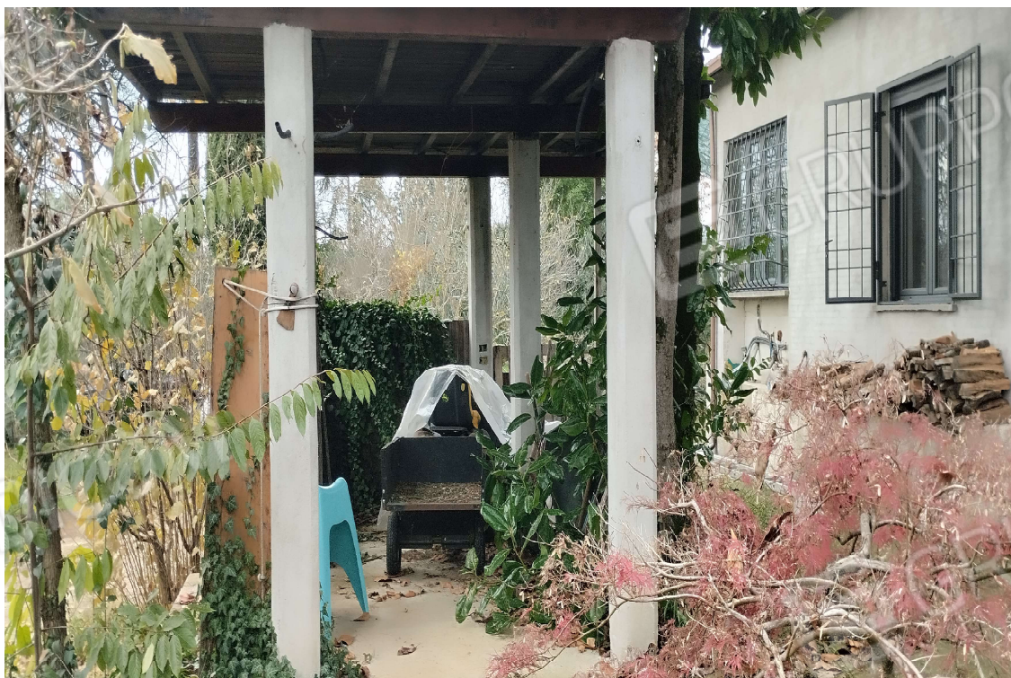
Tettoia in c.a. sul lato sud della casa
