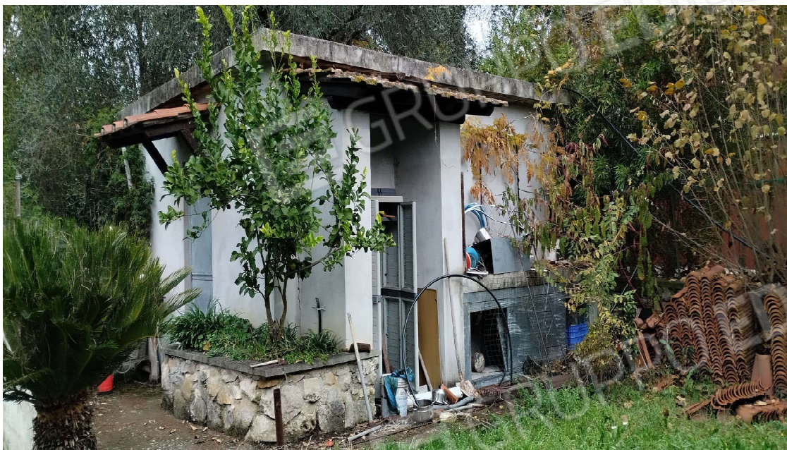
Vista ad angolo del magazzino
