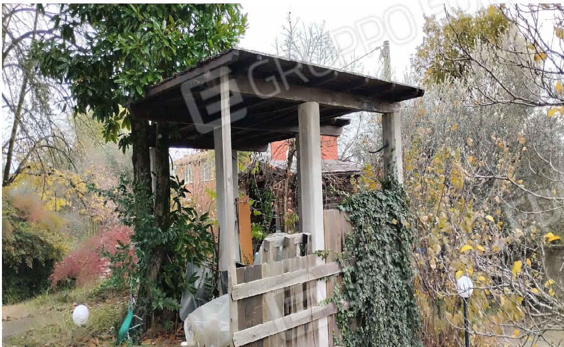
Altra vista della tettoia lato sud
