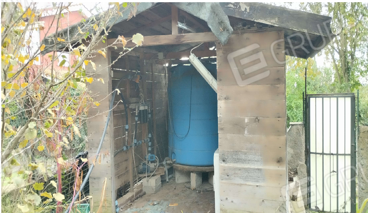
struttura in legno posta all'angolo est
