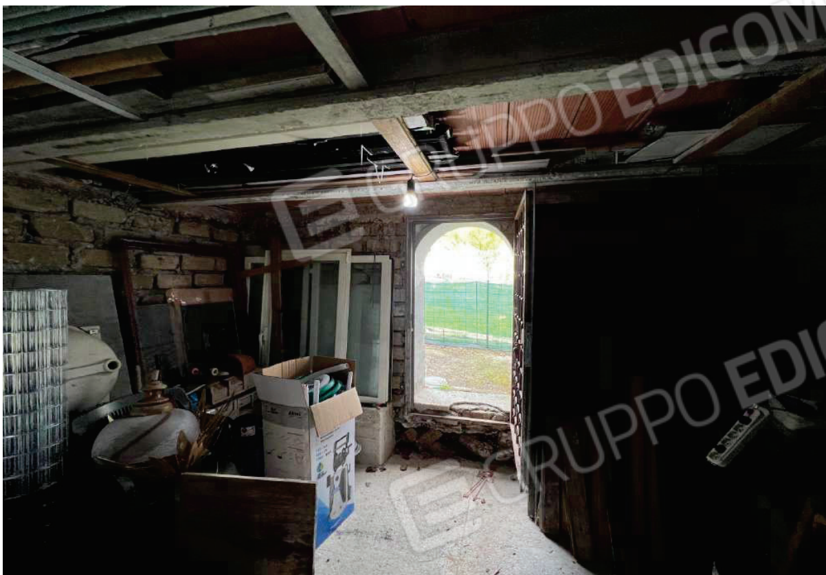
FOTO 13: Veduta interna vano deposito 2 piano S1
