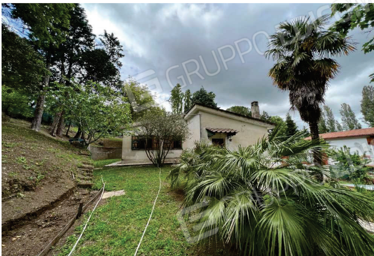
FOTO 1: Veduta esterna prospetto sud-est abitazione
