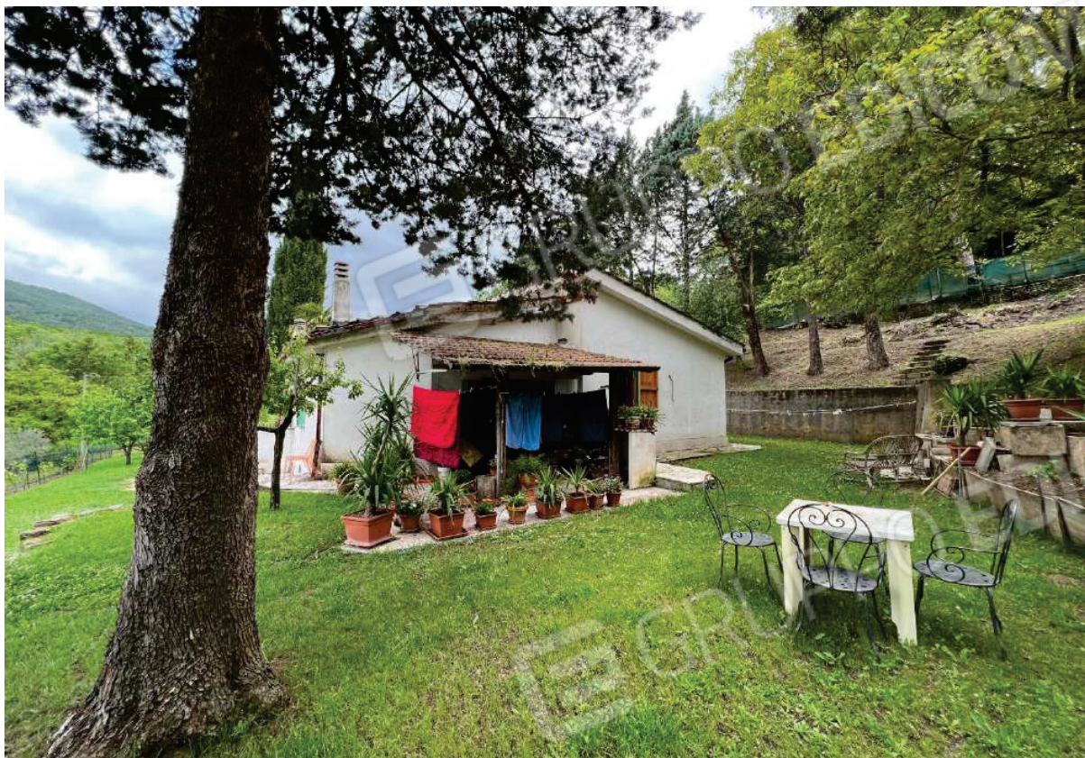
FOTO 3: Veduta esterna prospetto nord-ovest abitazione
