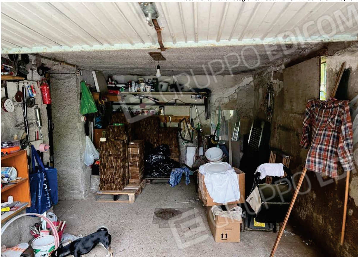
FOTO 11: Veduta interna vano garage piano S1
