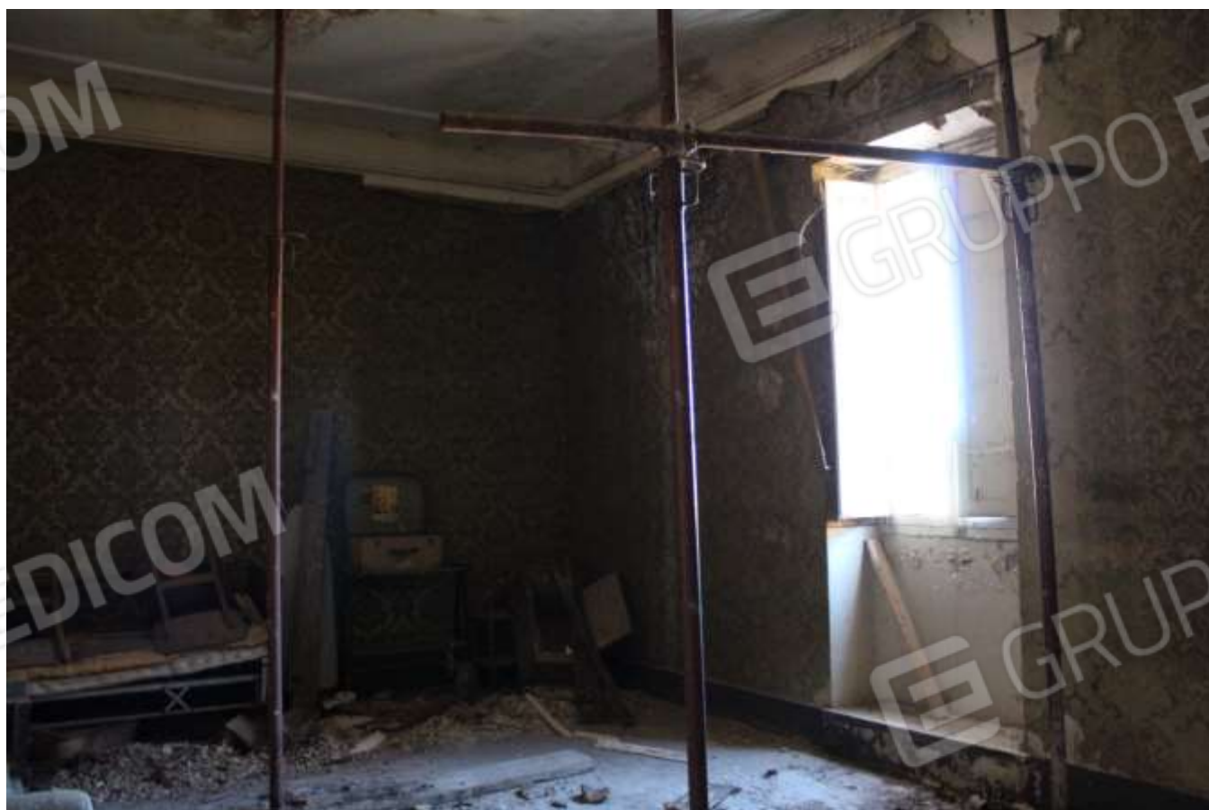
Foto 06 – Camera 1 (Piano Primo)
