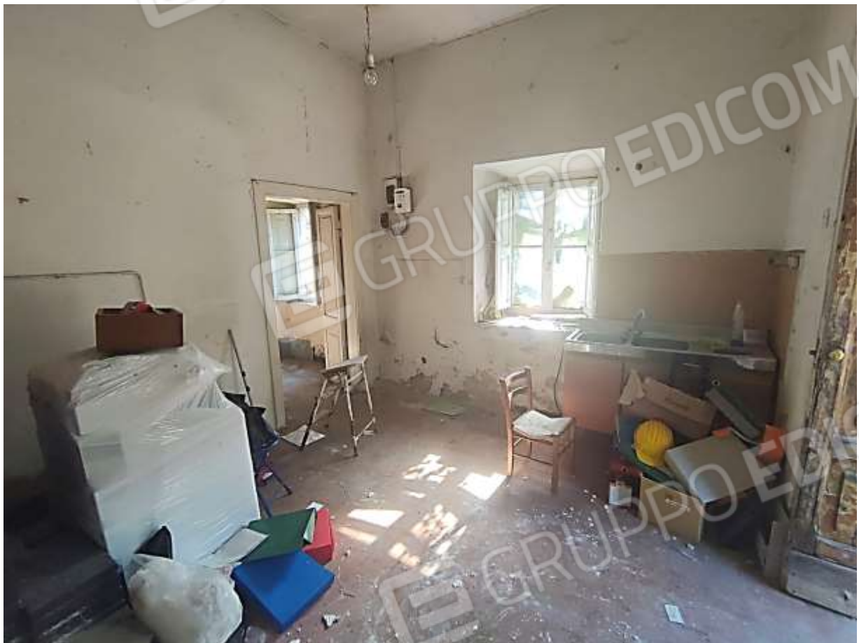
FOTO 03 - Fg. 89 P.Ila 9 (Abitazione - Tinello) Corpo 1E
