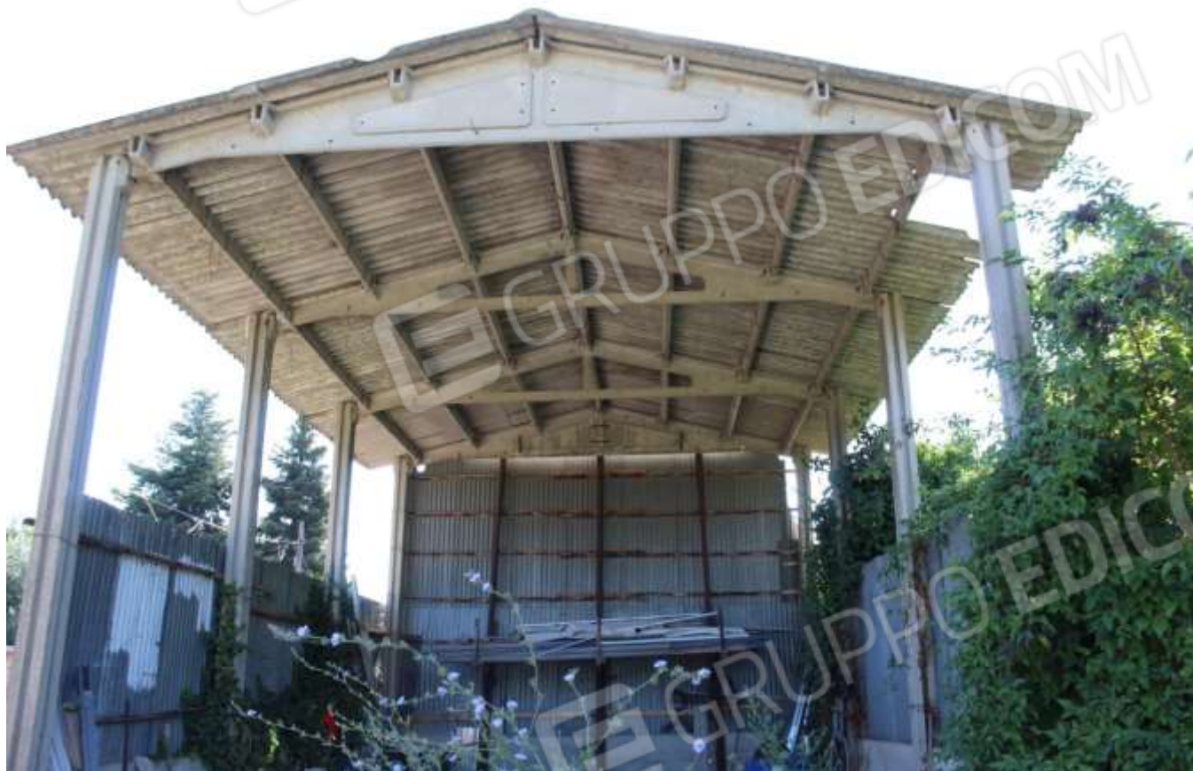
FOTO 11 – Fg. 89 P.la 267 (Locale di deposito) Corpo 2B
