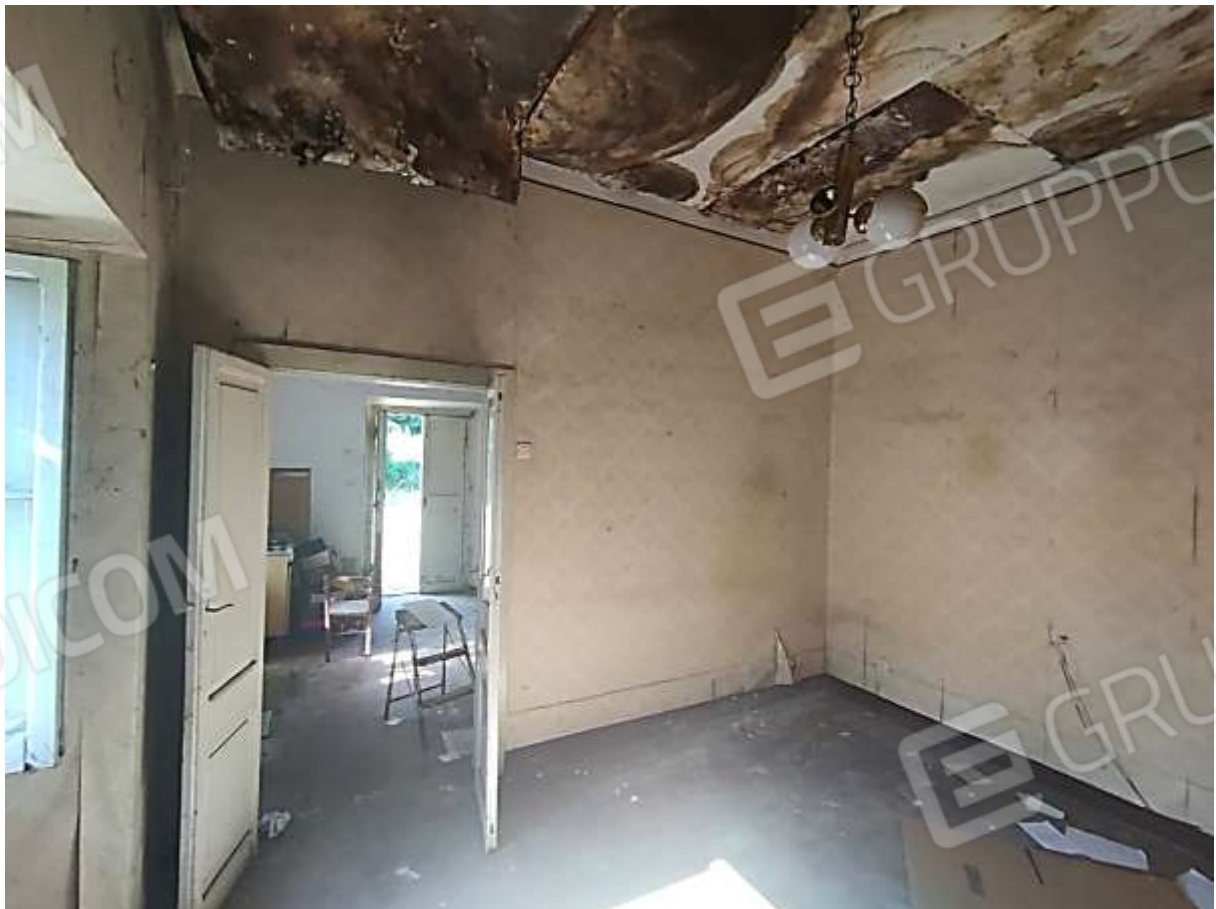
FOTO 04 – Fg. 89 P.Ila 9 (Abitazione – Camera 2) Corpo 1E
