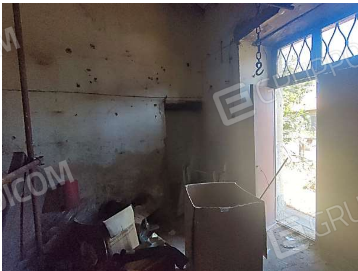
FOTO 08 – Fg. 89 P.Ila 9 (Cantina 1) Corpo 1E
