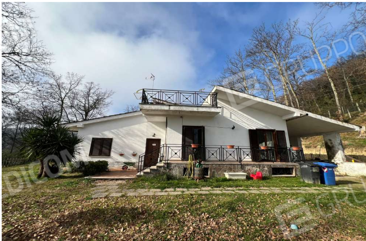
FOTO 2: Veduta esterna prospettiva nord-est
