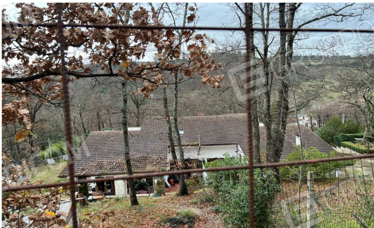
FOTO 4: Veduta esterna prospettiva nord-ovest
