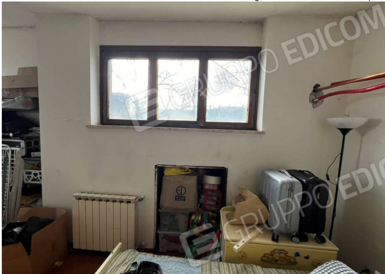
FOTO 11: Veduta interna vano ripostiglio piano 1
