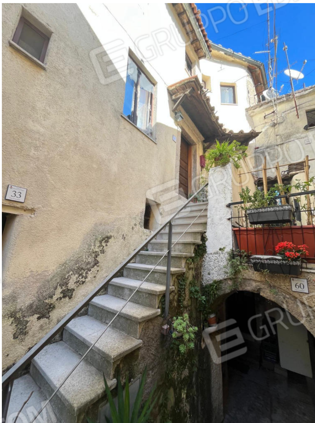
Foto n. 2 – Prospetto del fabbricato
