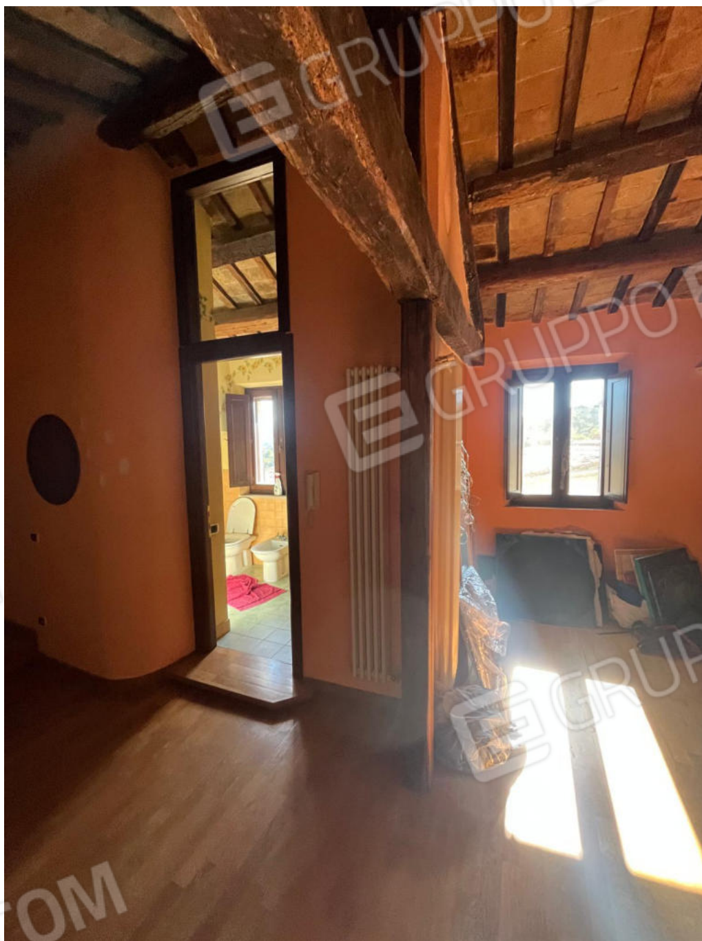
Foto n. 6 – Disimpegno piano secondo
