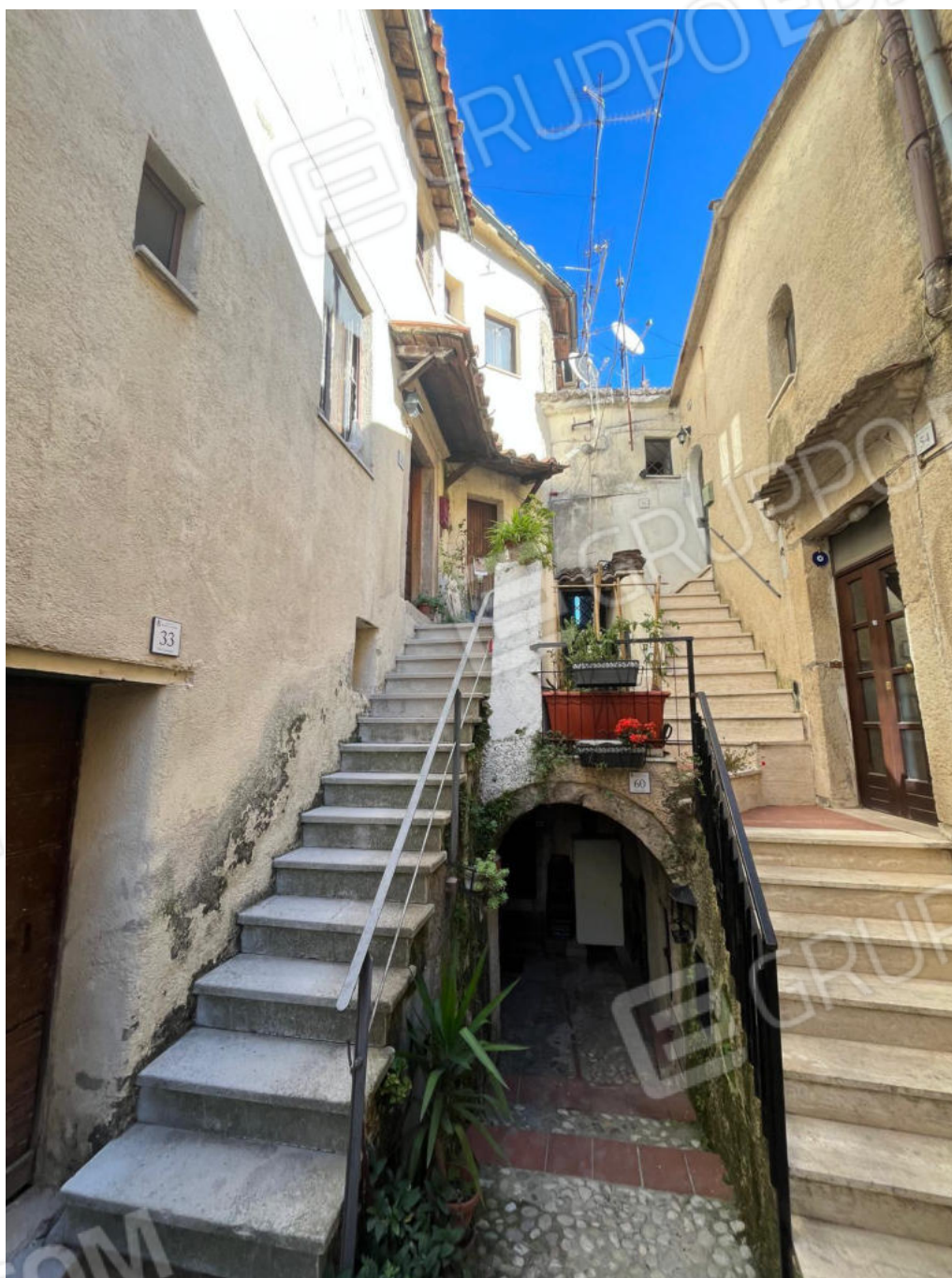
Foto n. 1 – Prospetto del fabbricato
