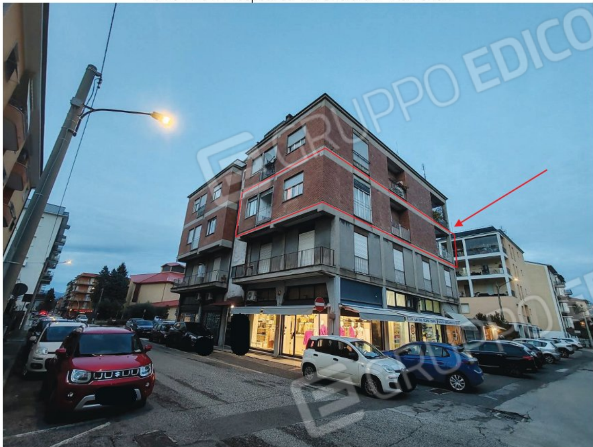
FOTO N°01: Prospetti su Via Gherardi + Via Ferrari.
