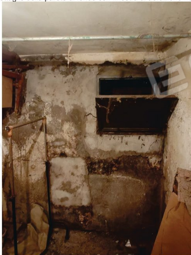
FOTO N°20: dettaglio della parete di fondo con finestra di aerazione nel locale cantina.
