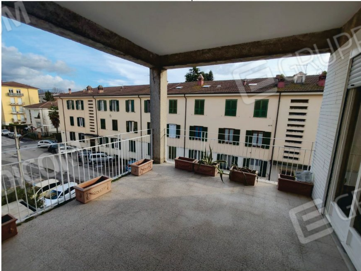
FOTO N°16: Terrazzo del reparto notte – foto 2di2..
