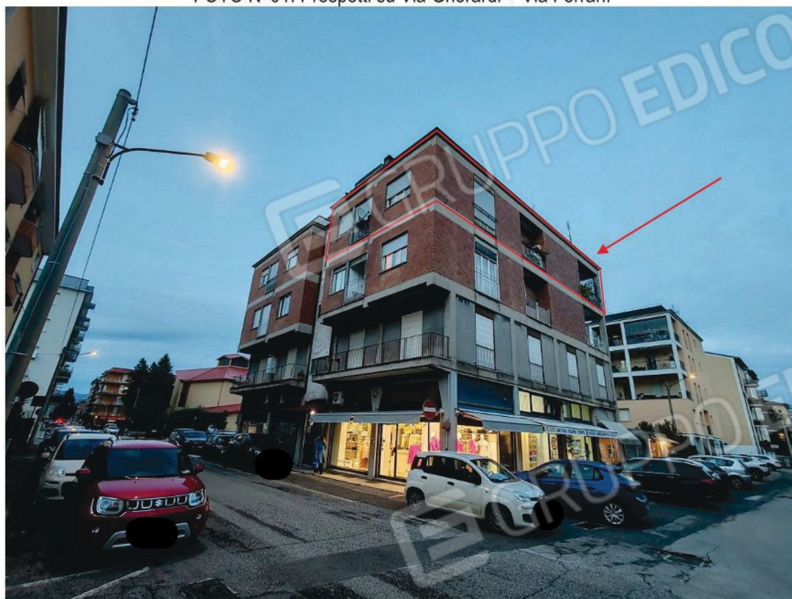
FOTO N°01: Prospetti su Via Gherardi + Via Ferrari.
