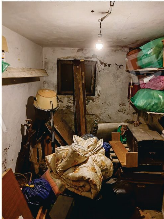
FOTO N°16: Interno della cantina del Sub.18.
