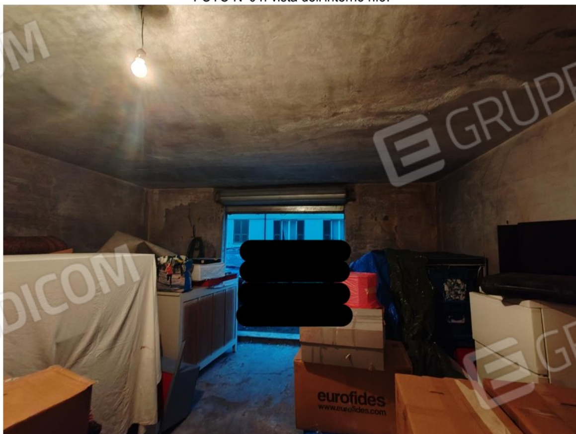
FOTO N°04: vista dell'interno n.3.
