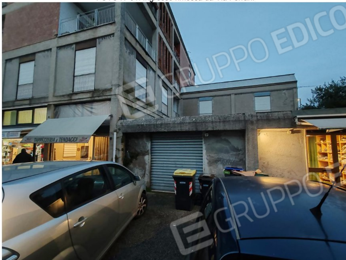
FOTO N°01: Ingresso rimessa da Via Ferrari.
