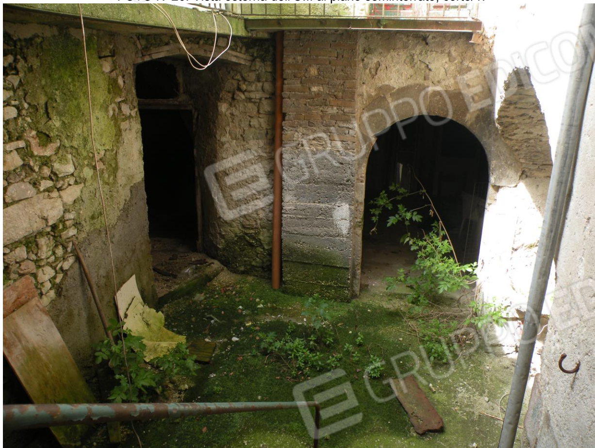
FOTO N°20: Vista esterna dell'U.I. al piano seminterrato, corte/1.
