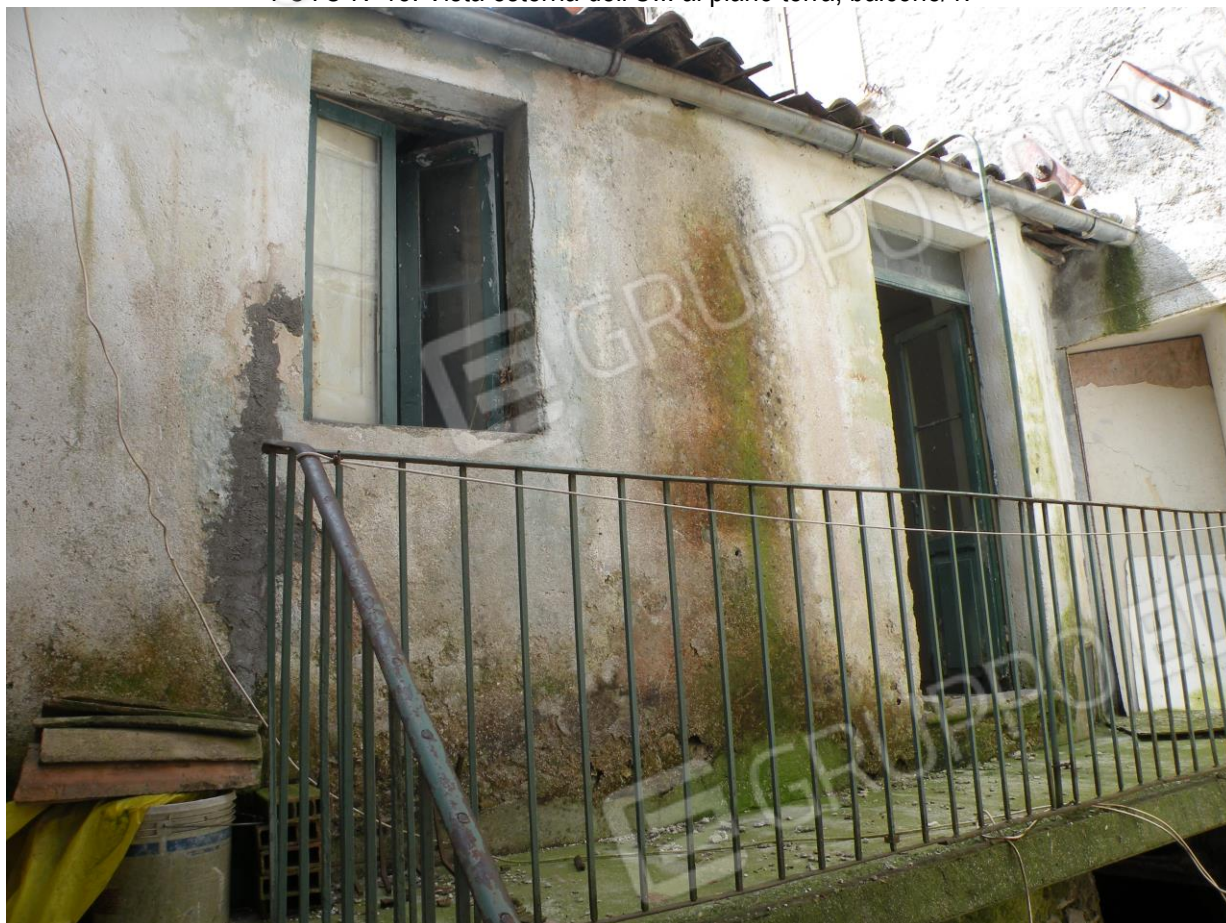
FOTO N°15: Vista esterna dell'U.I. al piano terra, balcone/1.
