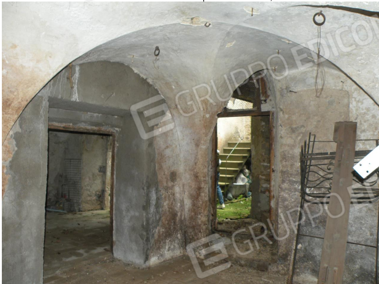
FOTO N°26: Vista interna dell'U.I. al piano seminterrato, cantina 1/1.
