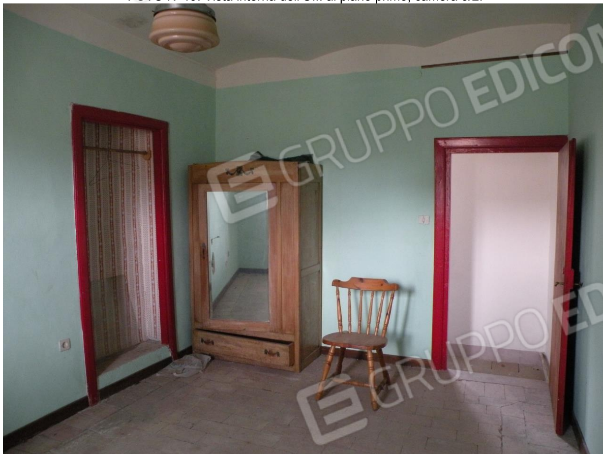
FOTO N°19: Vista interna dell'U.I. al piano primo, camera 3/2.
