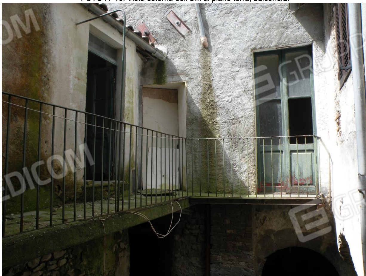
FOTO N°16: Vista esterna dell'U.I. al piano terra, balcone/2.
