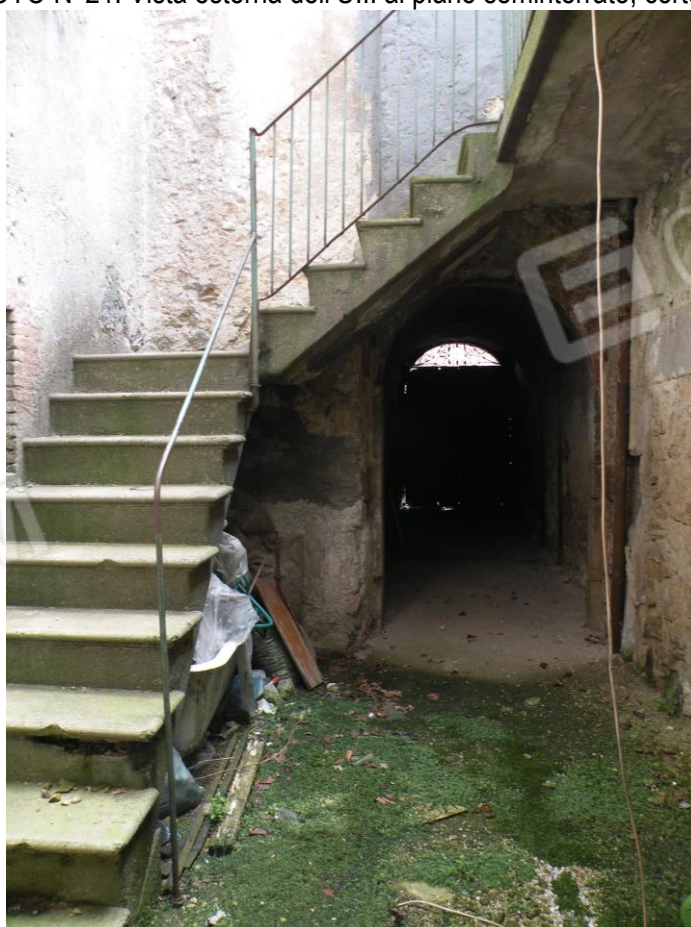
FOTO N°21: Vista esterna dell'U.I. al piano seminterrato, corte/2.
