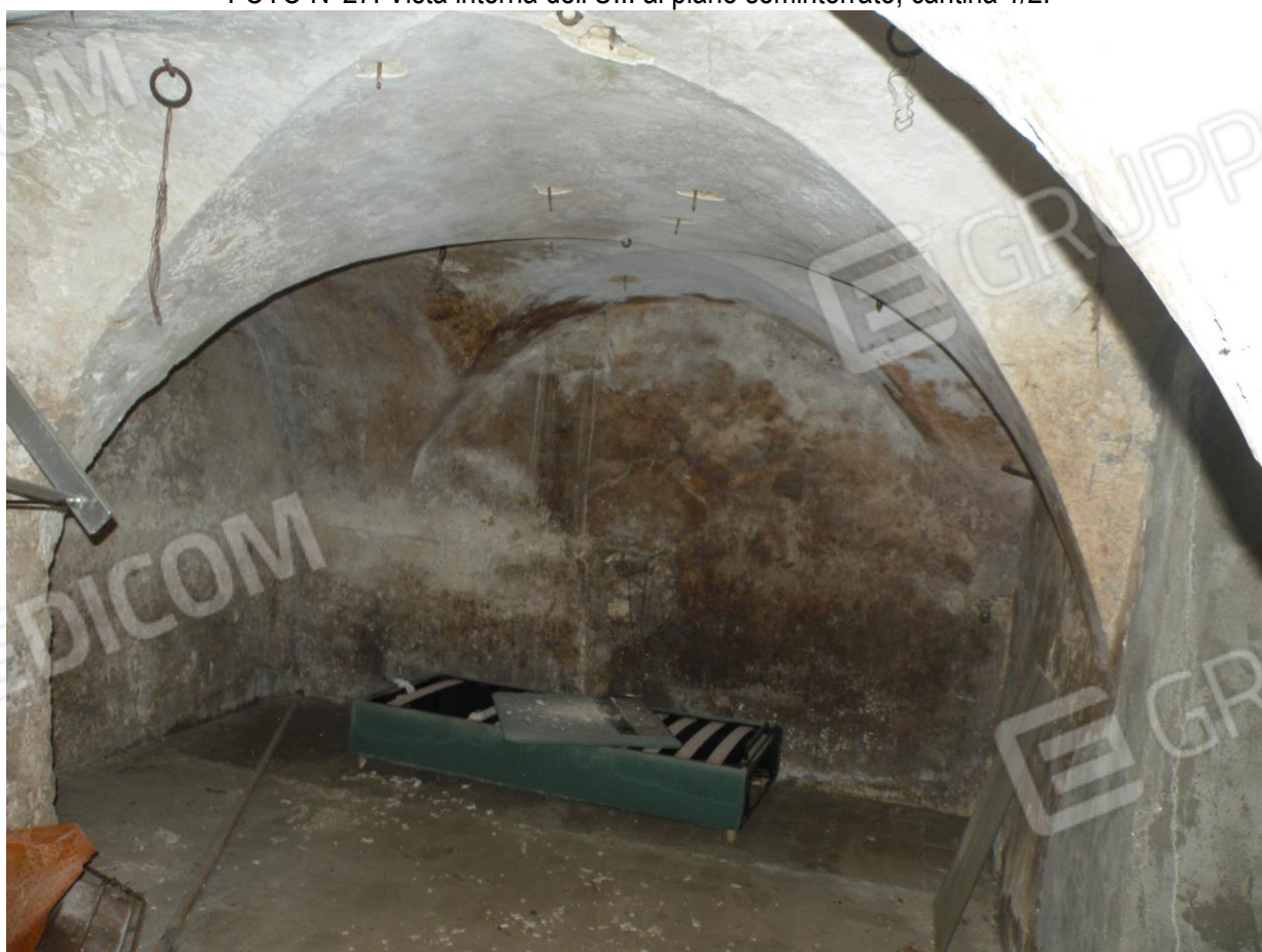
FOTO N°27: Vista interna dell'U.I. al piano seminterrato, cantina 1/2.
