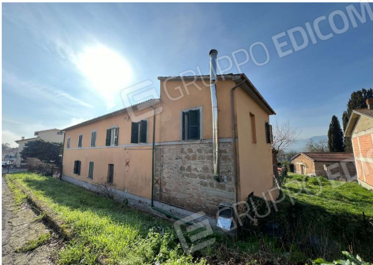
FOTO 3: Veduta esterna prospetto nord-est
