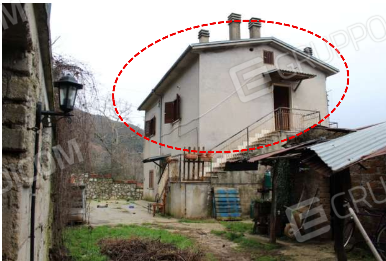
FOTO 4 – Abitazione (Lato Sud) Corpo “A”
