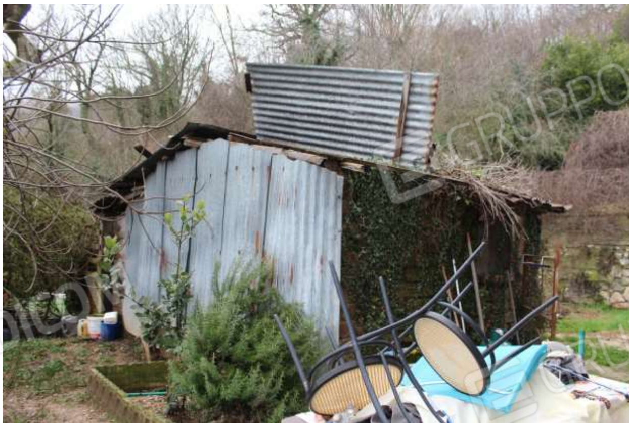
FOTO 6 – Magazzino (Lato Est) Corpo “C”
