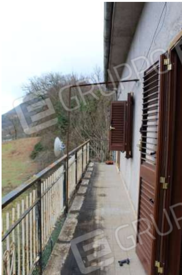
FOTO 11 – Balcone (Piano 1) - Corpo "A"
