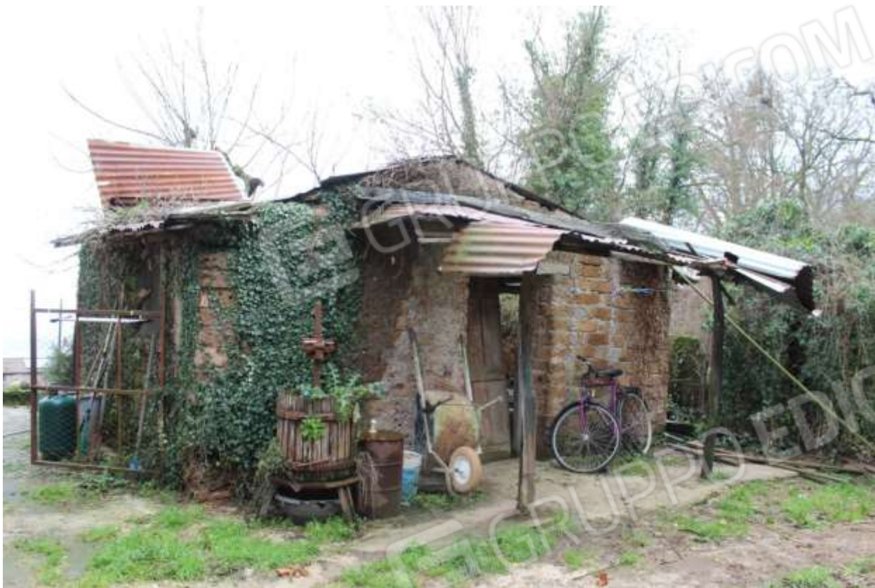
FOTO 5 – Magazzino (Lato Ovest) Corpo “C”
