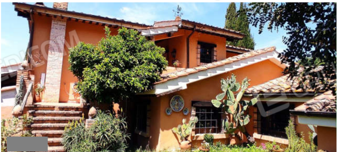
Foto 15 – Vista esterna, prospetto est
