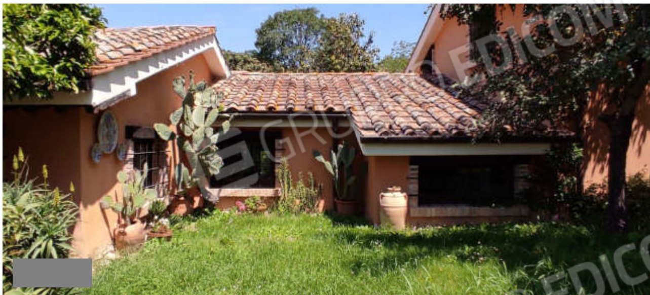
Foto 16 – Vista esterna, prospetto sud
