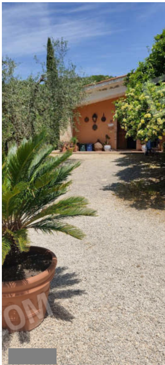
Foto 40 e 41 – vista eterna, prospetti ovest e nord
