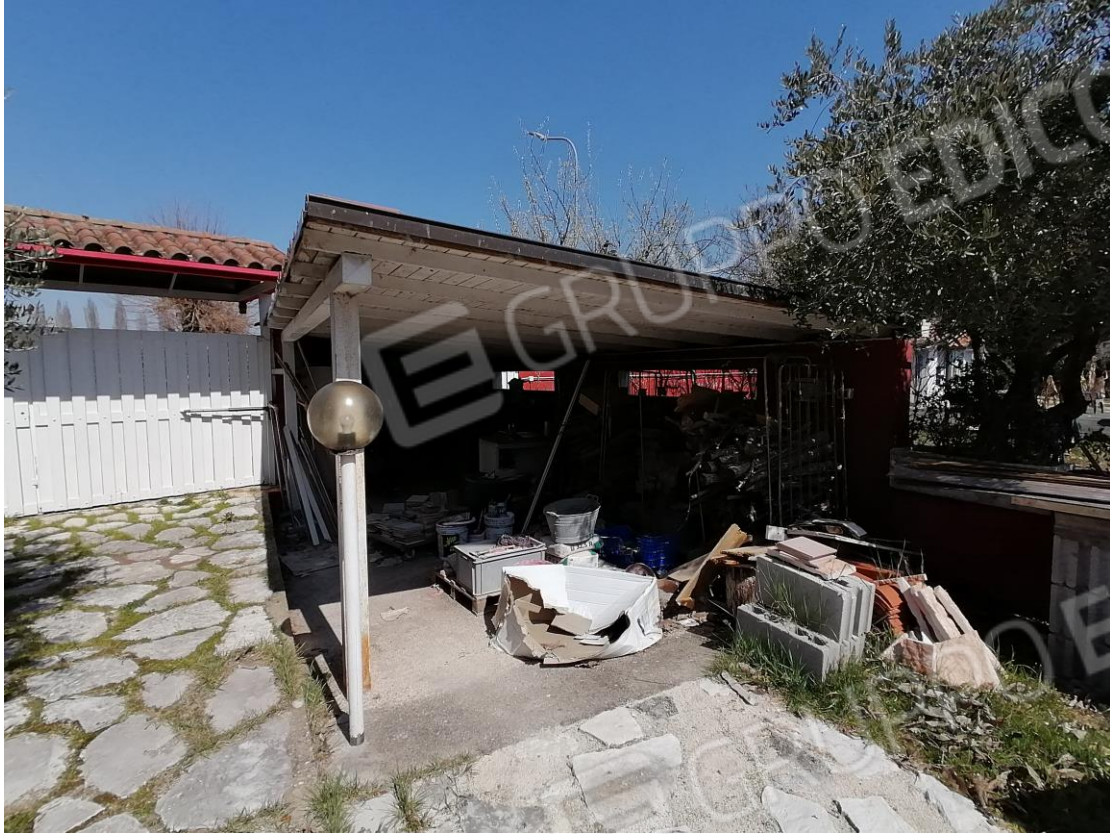
FOTO N°52: Tettoia esterna al Piano di Campagna – Vista frontale.
