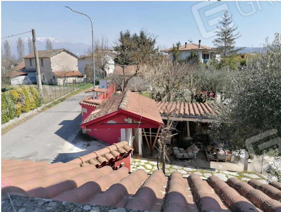
FOTO N°51: Tettoia esterna al Piano di Campagna.
