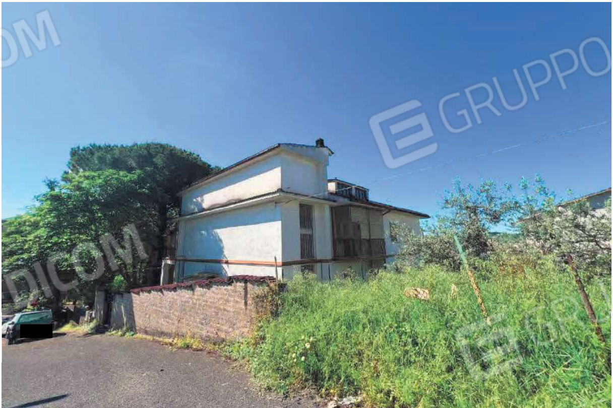
FOTO 2: Veduta esterna prospettiva nord-est
