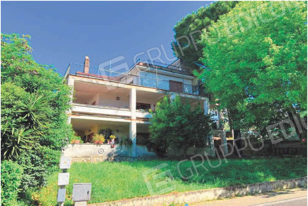
FOTO 1: Veduta esterna prospettiva sud-ovest
