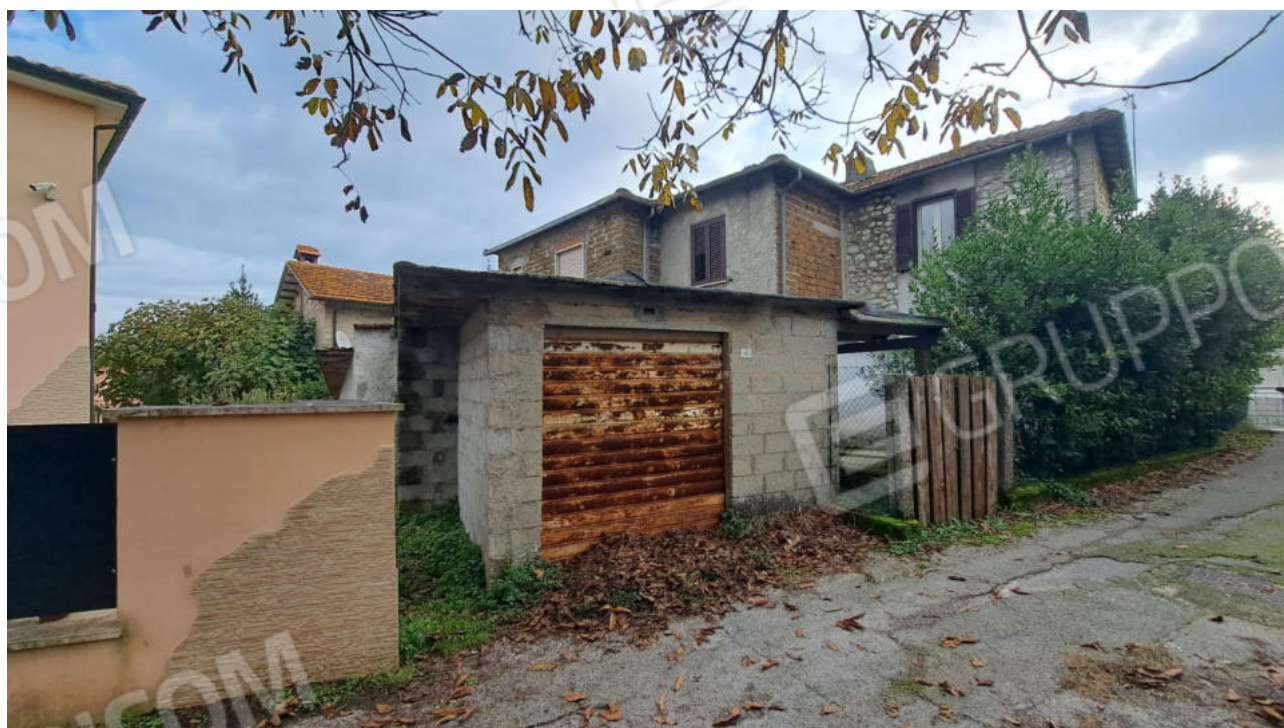
Vedute esterne del fabbricato – prospetto posteriore
