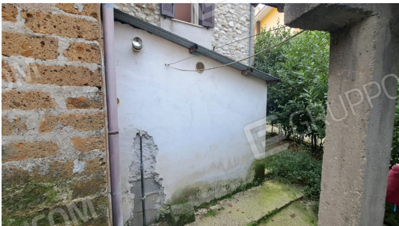
Vedute esterne del fabbricato (corte sub 3)
