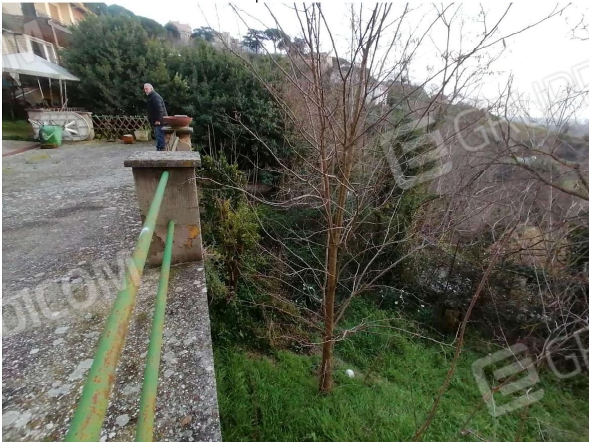
FOTO N°36: corte al piano sottostrada – zona scoscesa.
