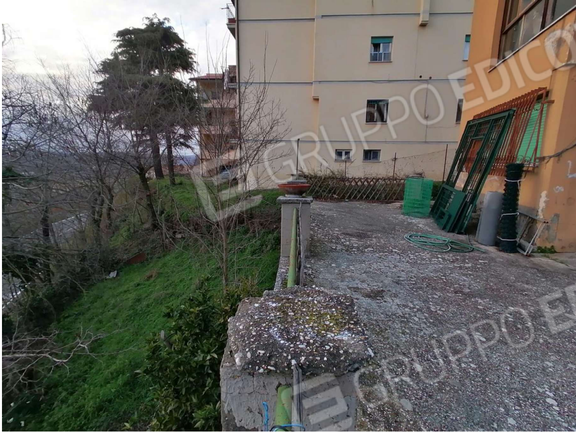
FOTO N°35 Corte esterna pavimentata (quota piano sottostrada).
