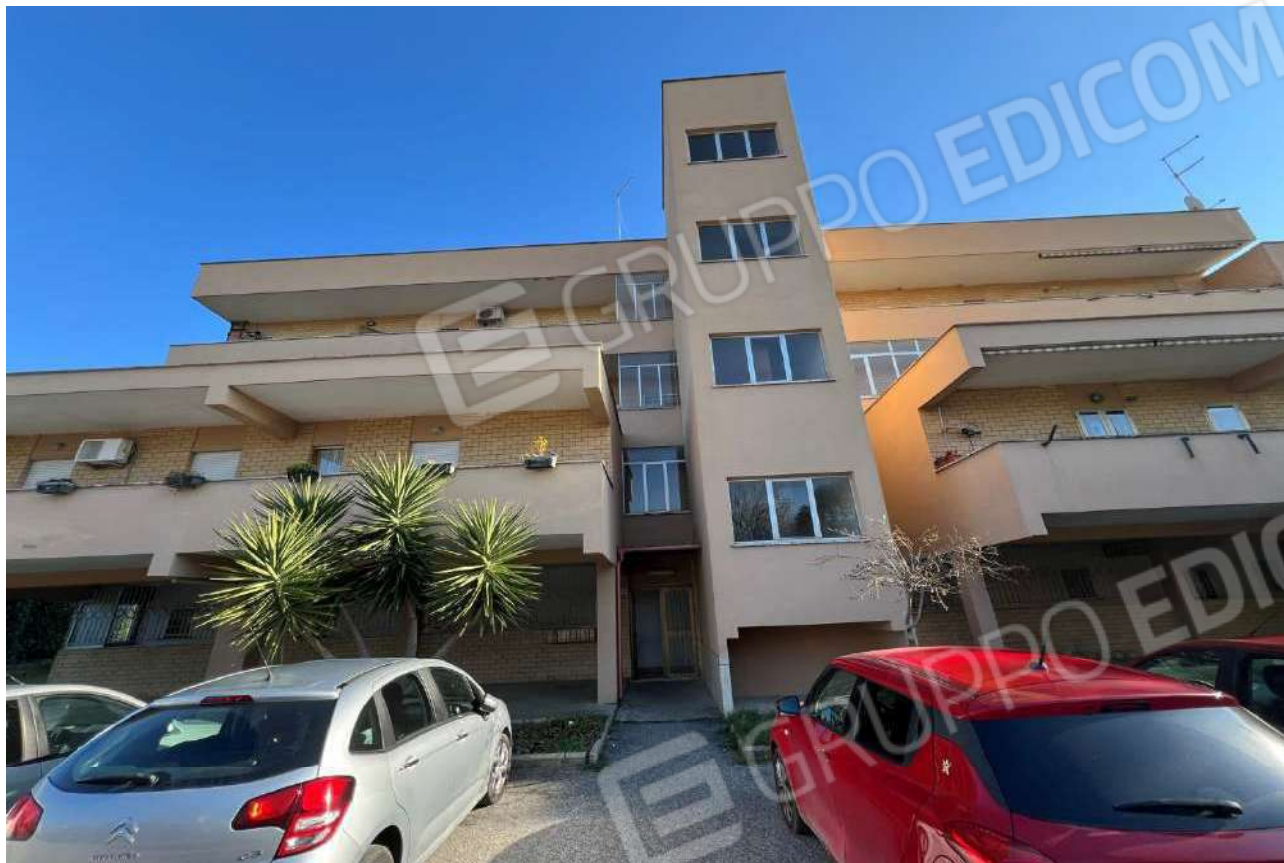
FOTO 1: Veduta esterna prospettivo principale
