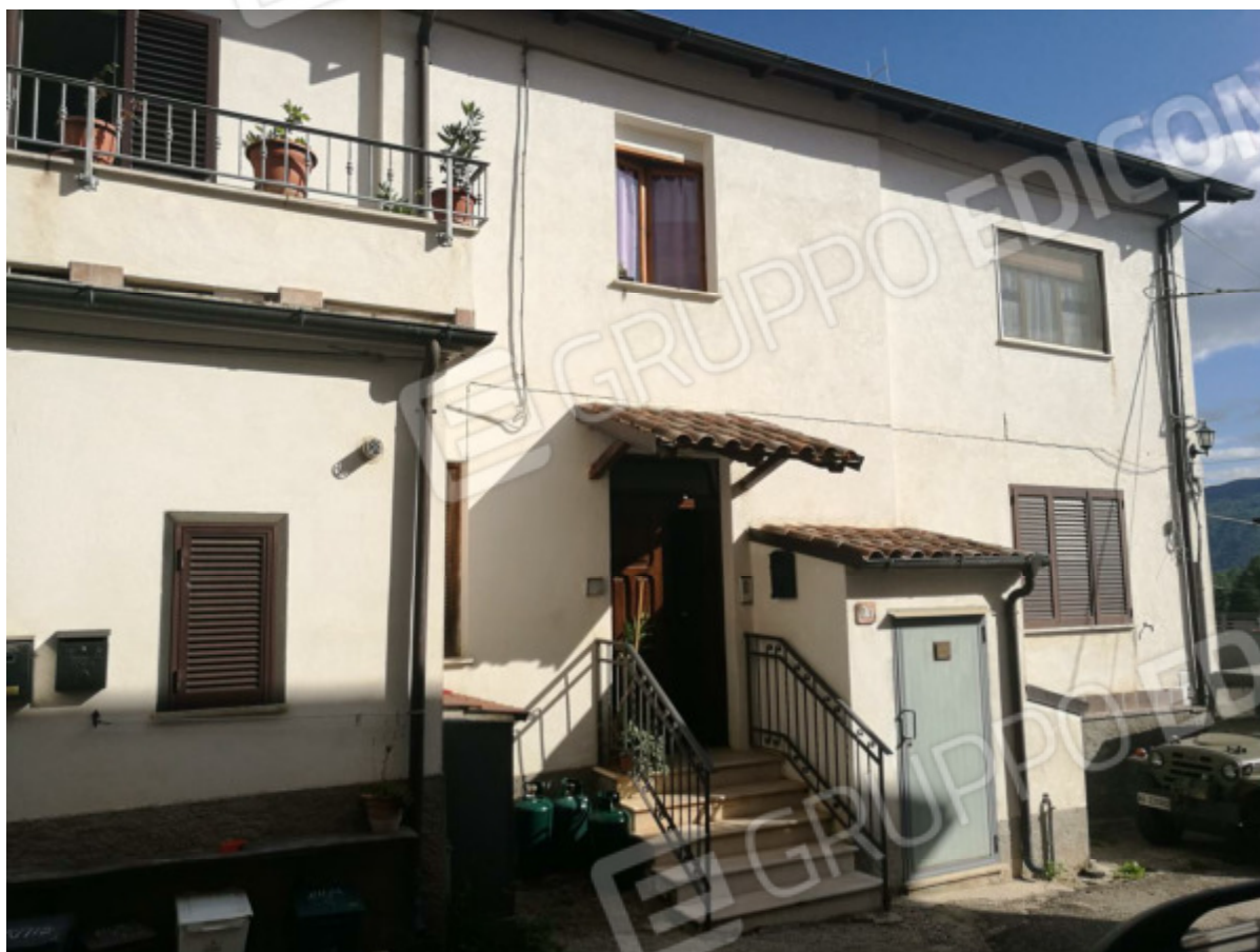
Foto 3 – Vista esterna dell'abitazione – Lato Nord/Ovest
