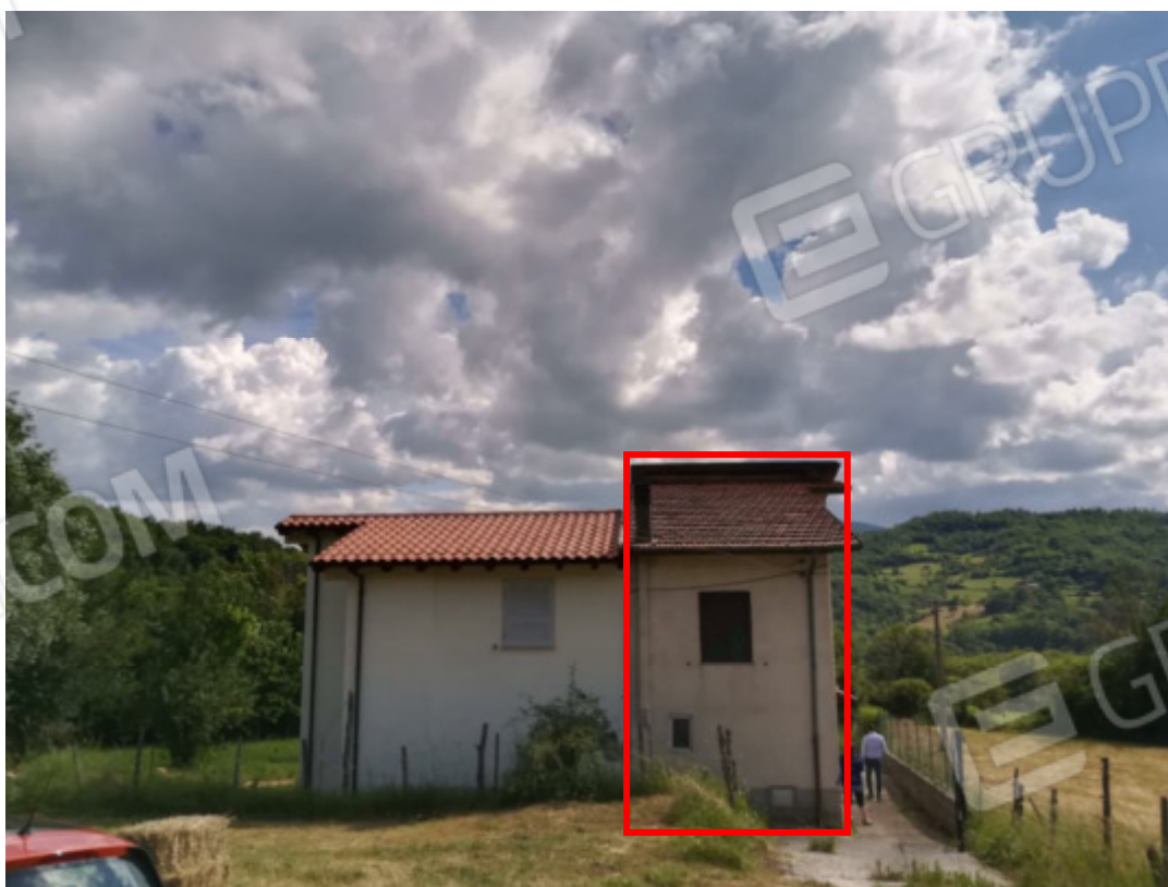
Foto 4 – Vista esterna dell'abitazione – lato Nord/Est
