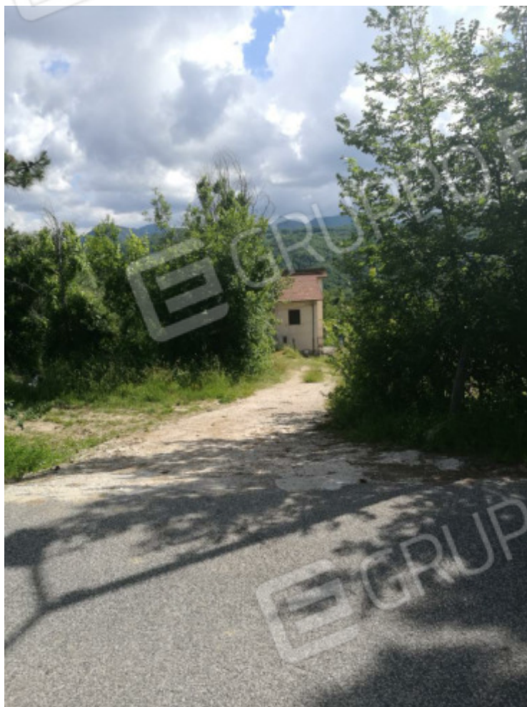
Foto 3 – Vista esterna dell'abitazione – Accesso da S.P. n°22
