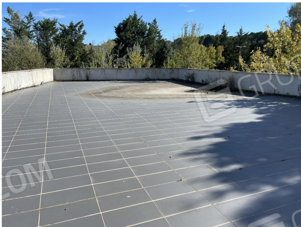
Fotografia n.33 – Piano Primo – Visuale del Portico Solare.
