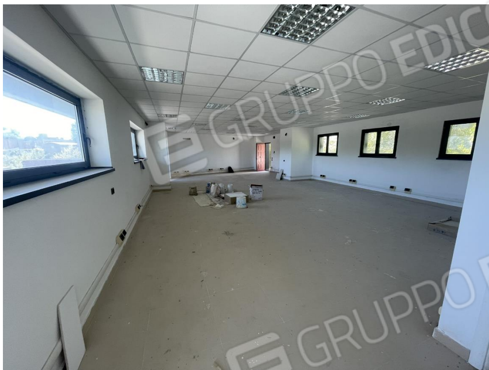
Fotografia n.28 – Piano Primo – Visuale interna dell'Ambiente Ufficio Tipo.
