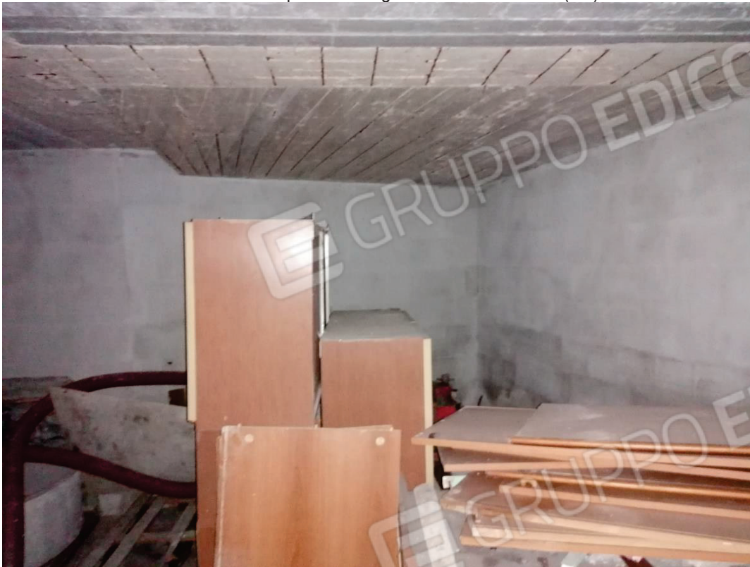
FOTO N°31: Corpo D – Garage – Piano Sottostrada (2/2).
