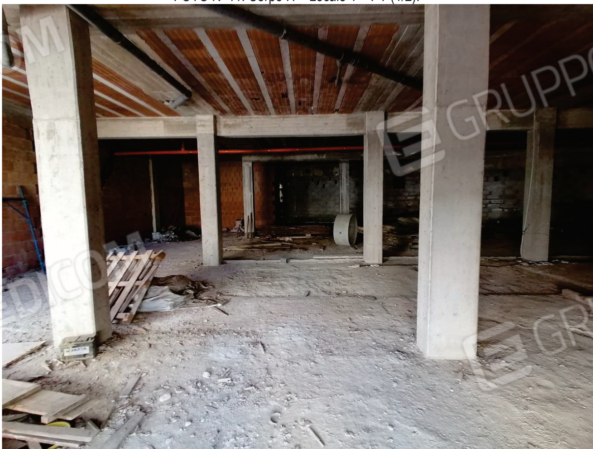
FOTO N°41: Corpo H – Locale 1 – PT (1/2).
