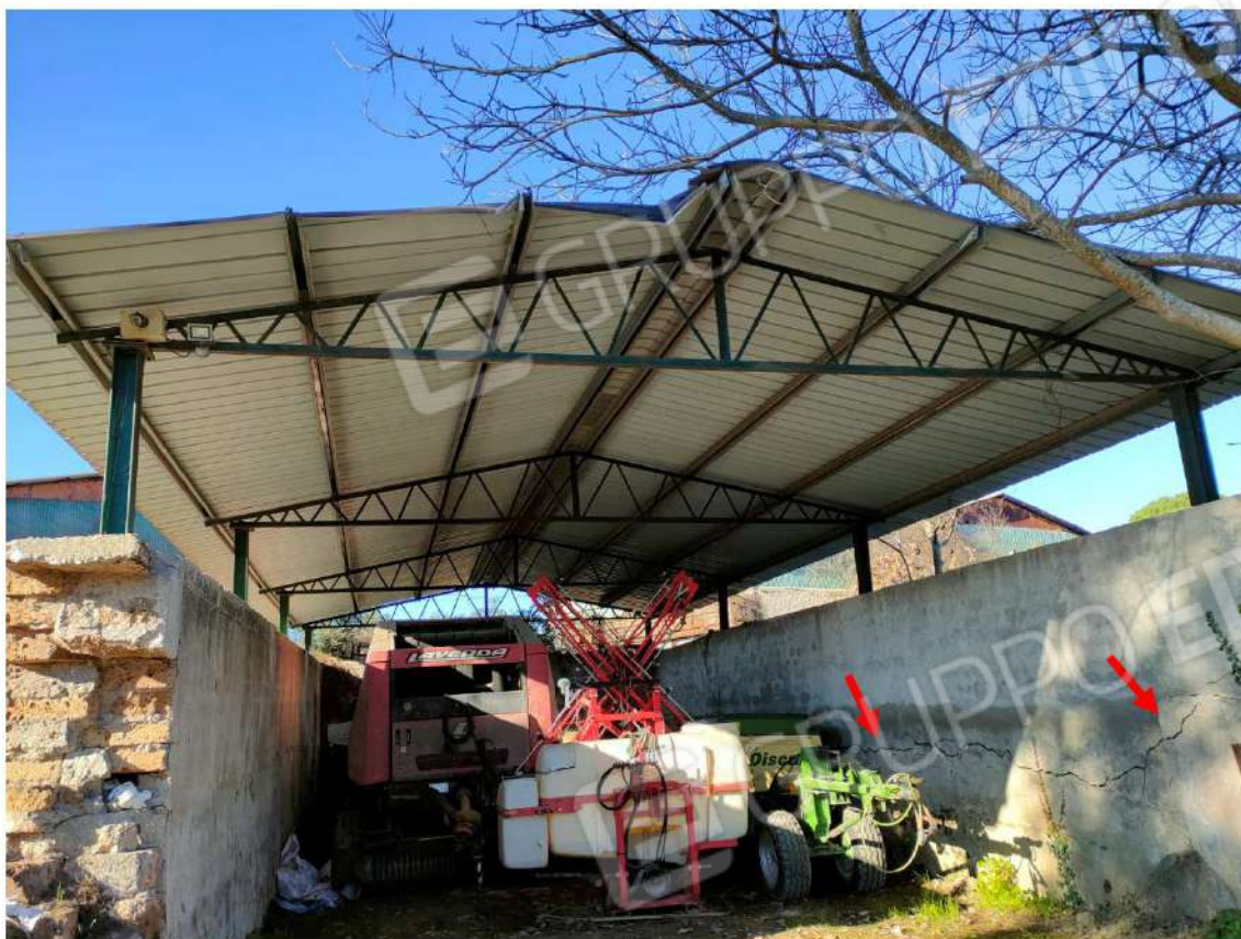
Fabbricato C - Tettoia Fienile
