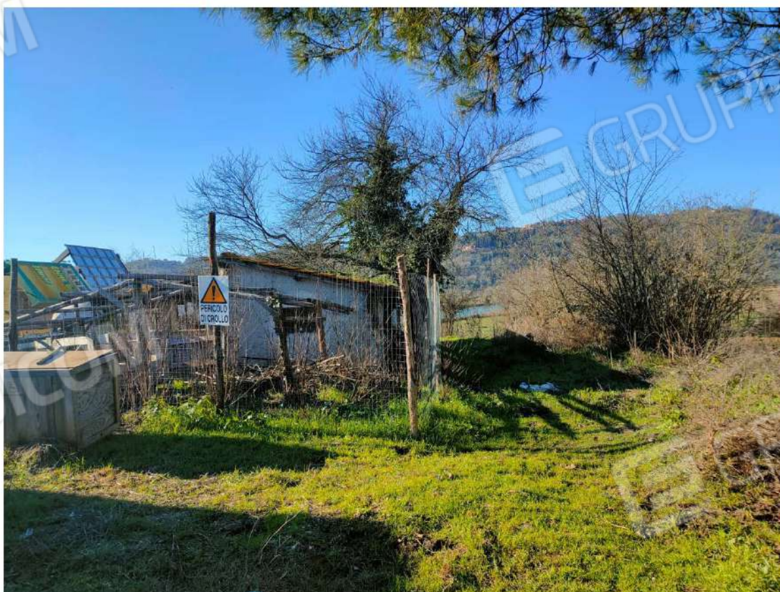
Fabbricato F - Porcilaia
