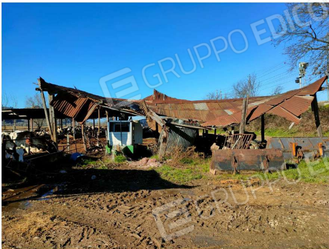
Fabbricato U – Tettoia Fienile
