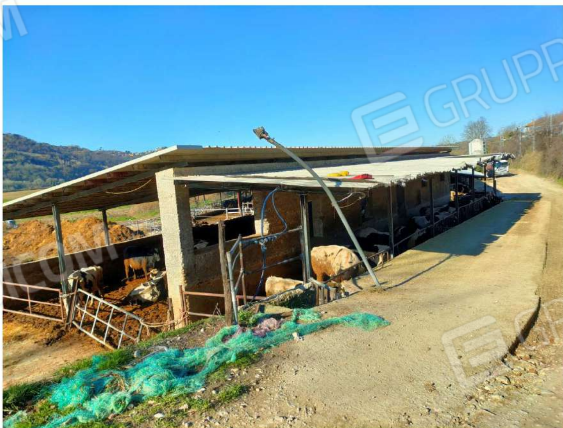
Fabbricato L – Tettoia Alimentazione
