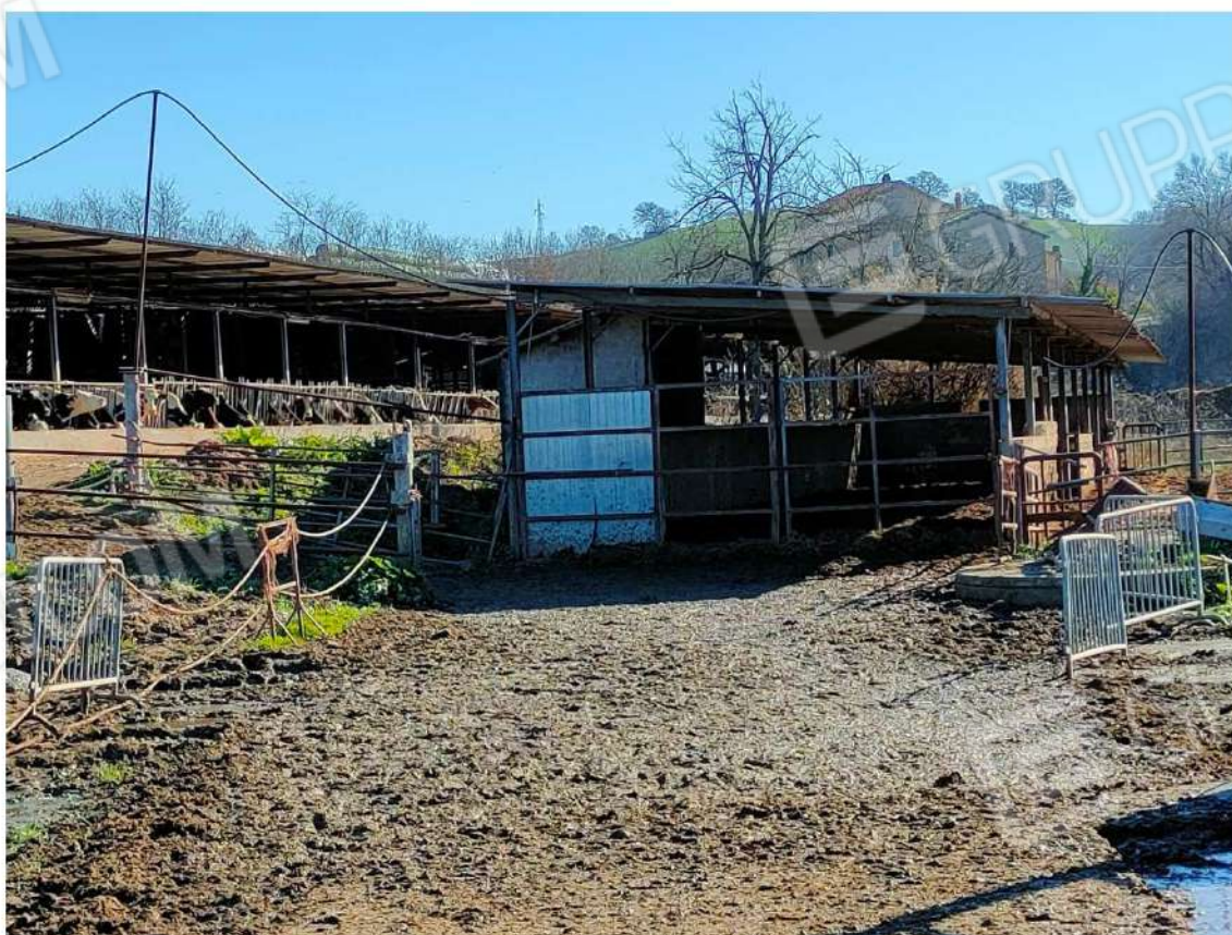
Fabbricato Q – Tettoia Alimentazione e Ricovero Vitelli
