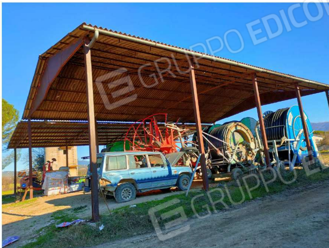
Fabbricato A - Tettoia Fienile
