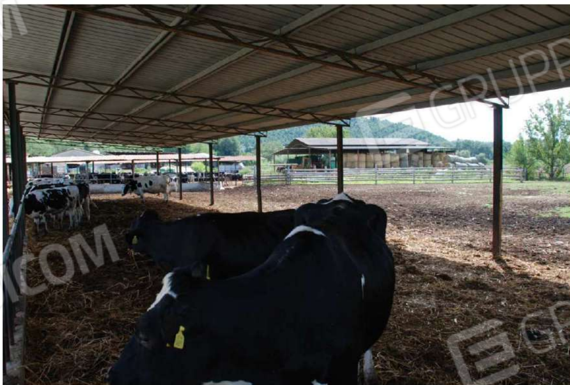
Fabbricato V – Tettoia Fienile
