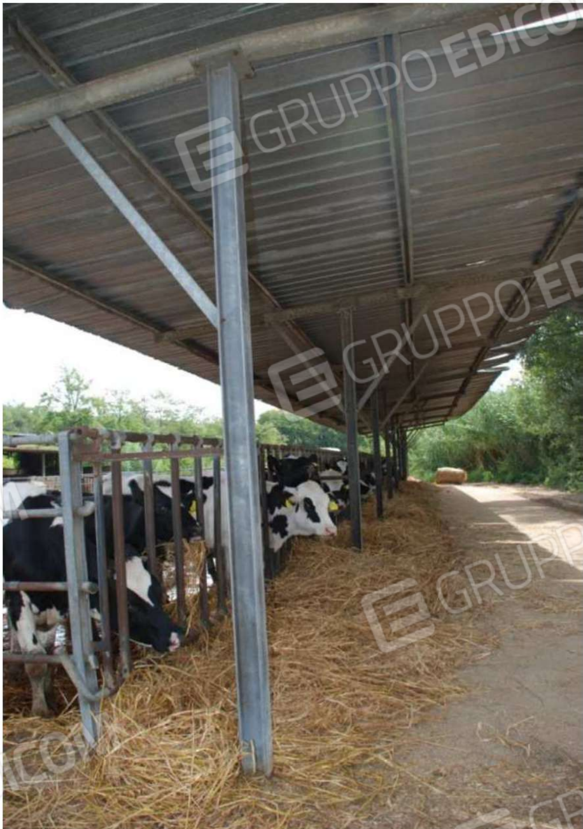
Fabbricato R – Tettoia Alimentazione
