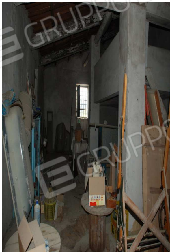
Piano Terra –granaio (interno)
