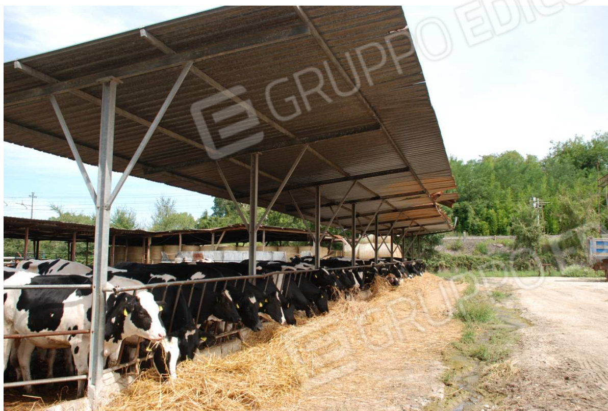
T - Tettoia Alimentazione
