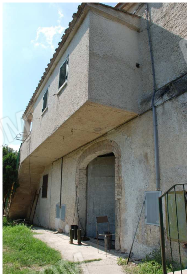
Piano Terra – ingresso granaio
