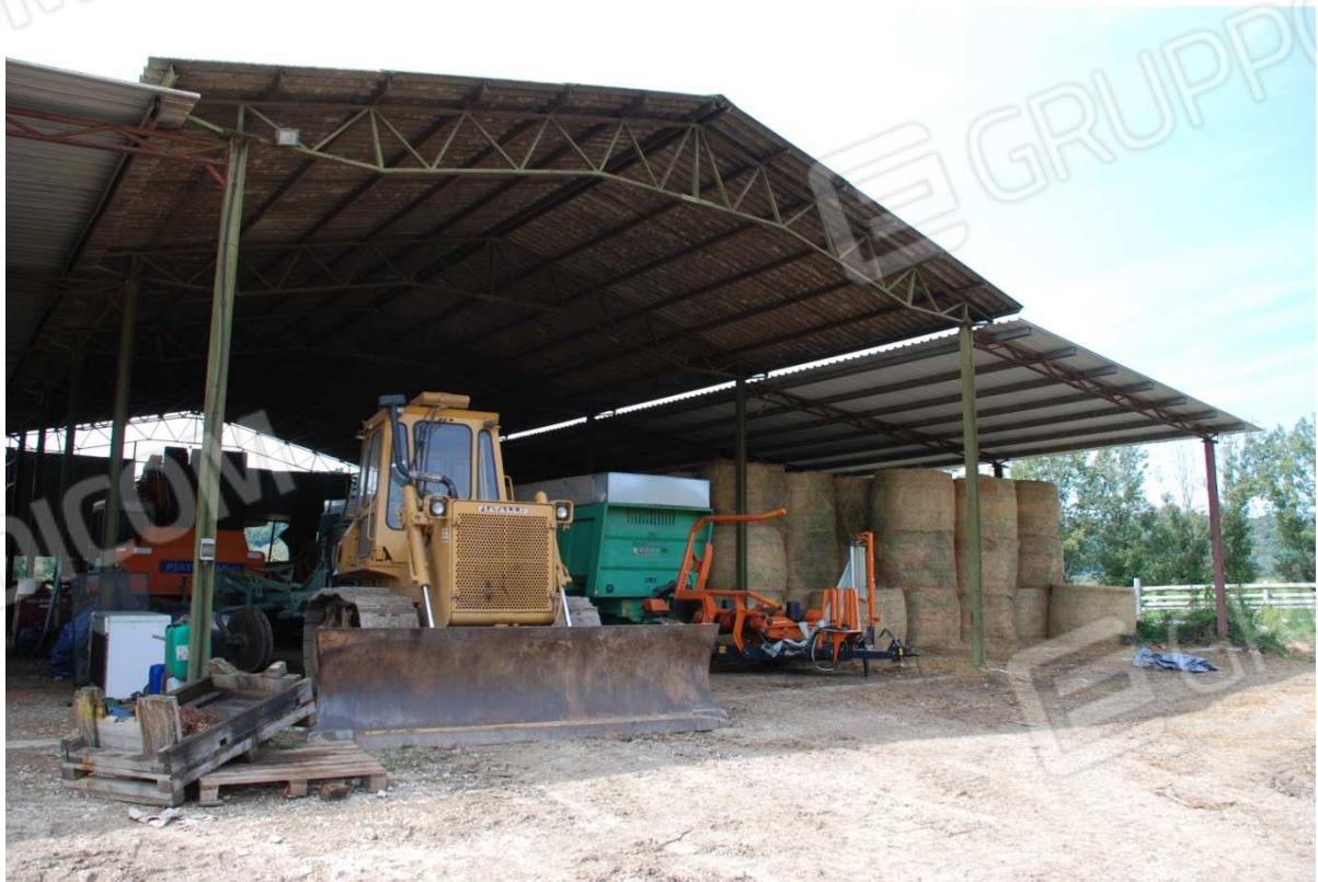
S - Tettoia Fienile/Rimessa macchine
