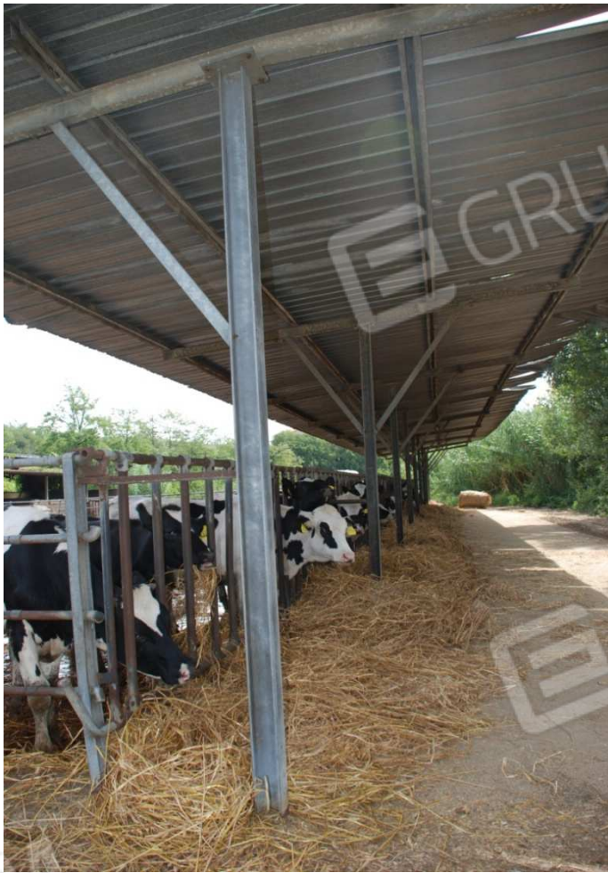
R – Tettoia Alimentazione
