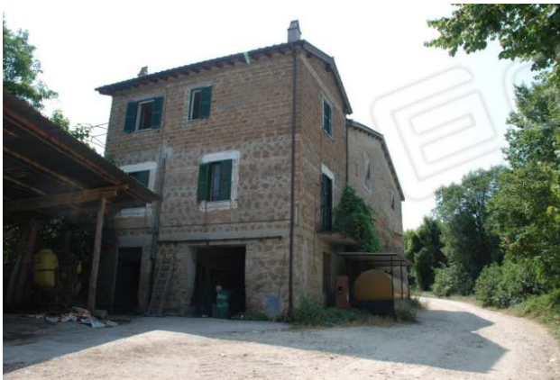
Part. 424 - facciate Nord e Ovest
