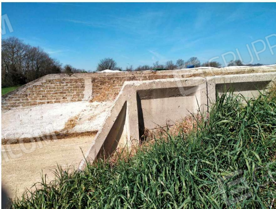
Comune Poggio Mirteto loc. Scalo – via Ferrovia n. 9 – Vista trincea per insilati (particolari costruttivi muri controterra)
