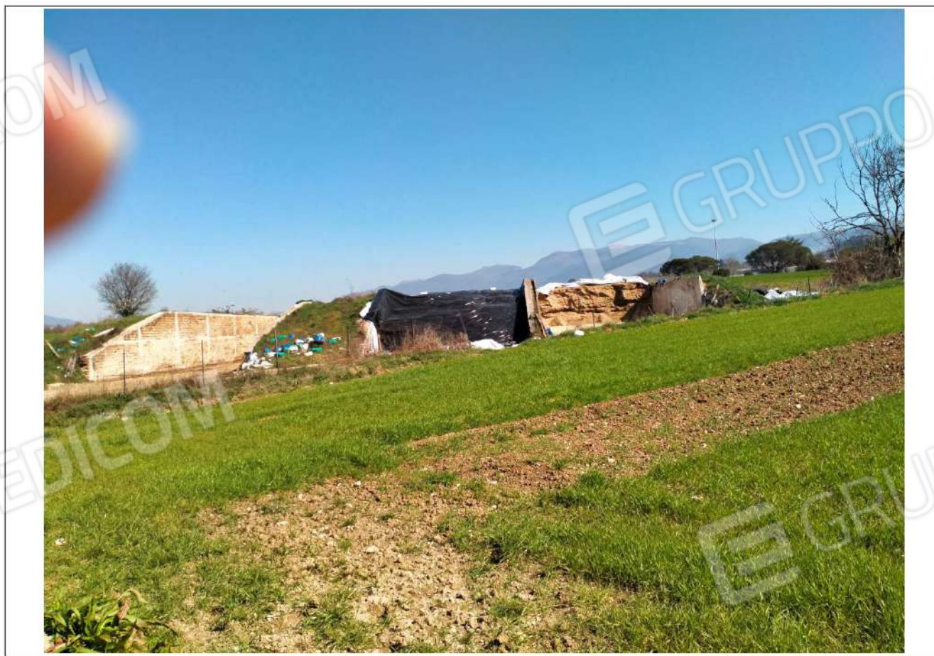
Comune Poggio Mirteto loc. Scalo – via Ferrovia n. 9 – Vista trincea per insilati
