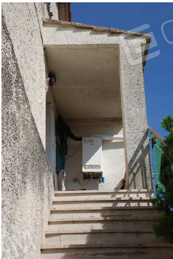
Scala di accesso
