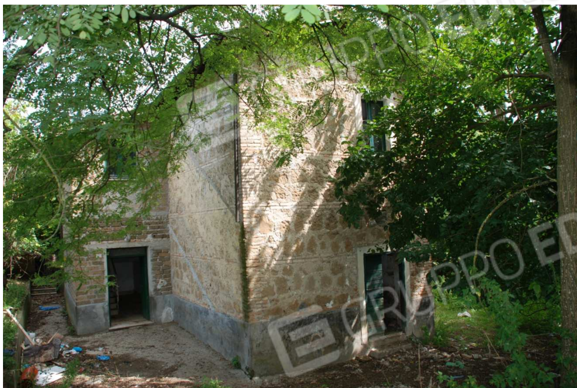
Fabbricato distinto fgl 10 part. 426 (A/7)
