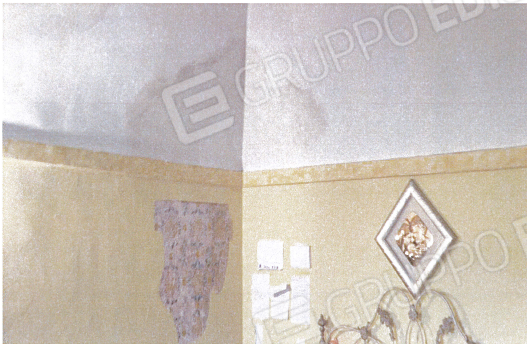
Altre macchie di umidità sul soffitto e sulle pareti della camera
