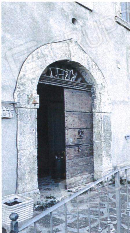
Particolare portone di accesso
