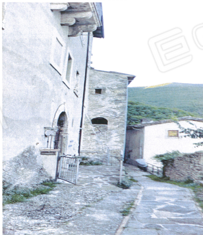
Vista esterna accesso abitazione da sud
