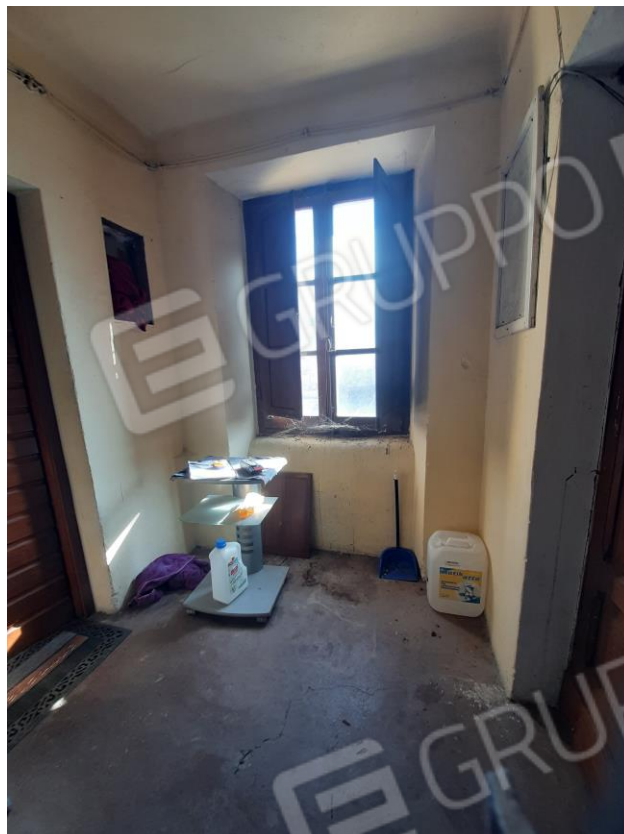
Pianerottolo piano primo, vano scala, ingresso alloggio (a destra)
