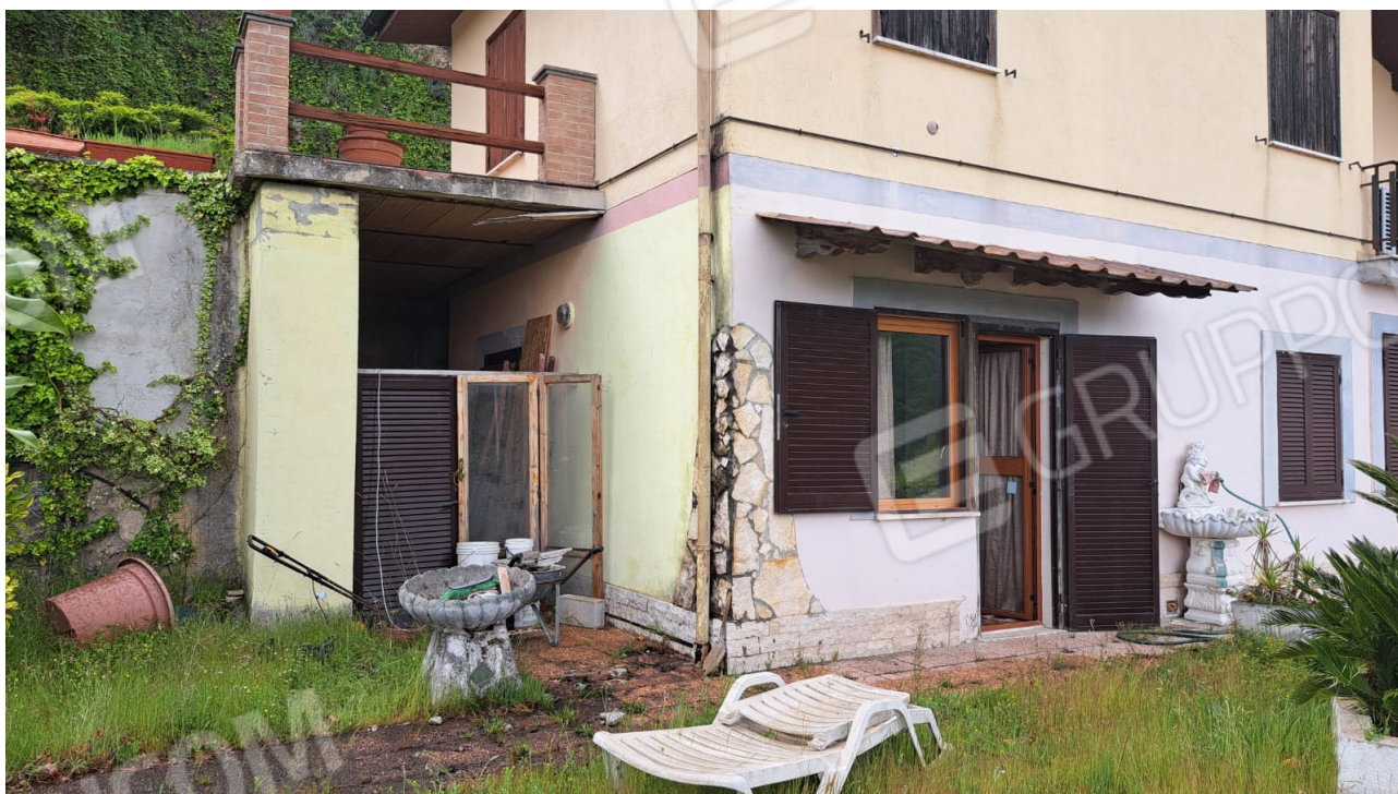
Vedute esterne del fabbricato
