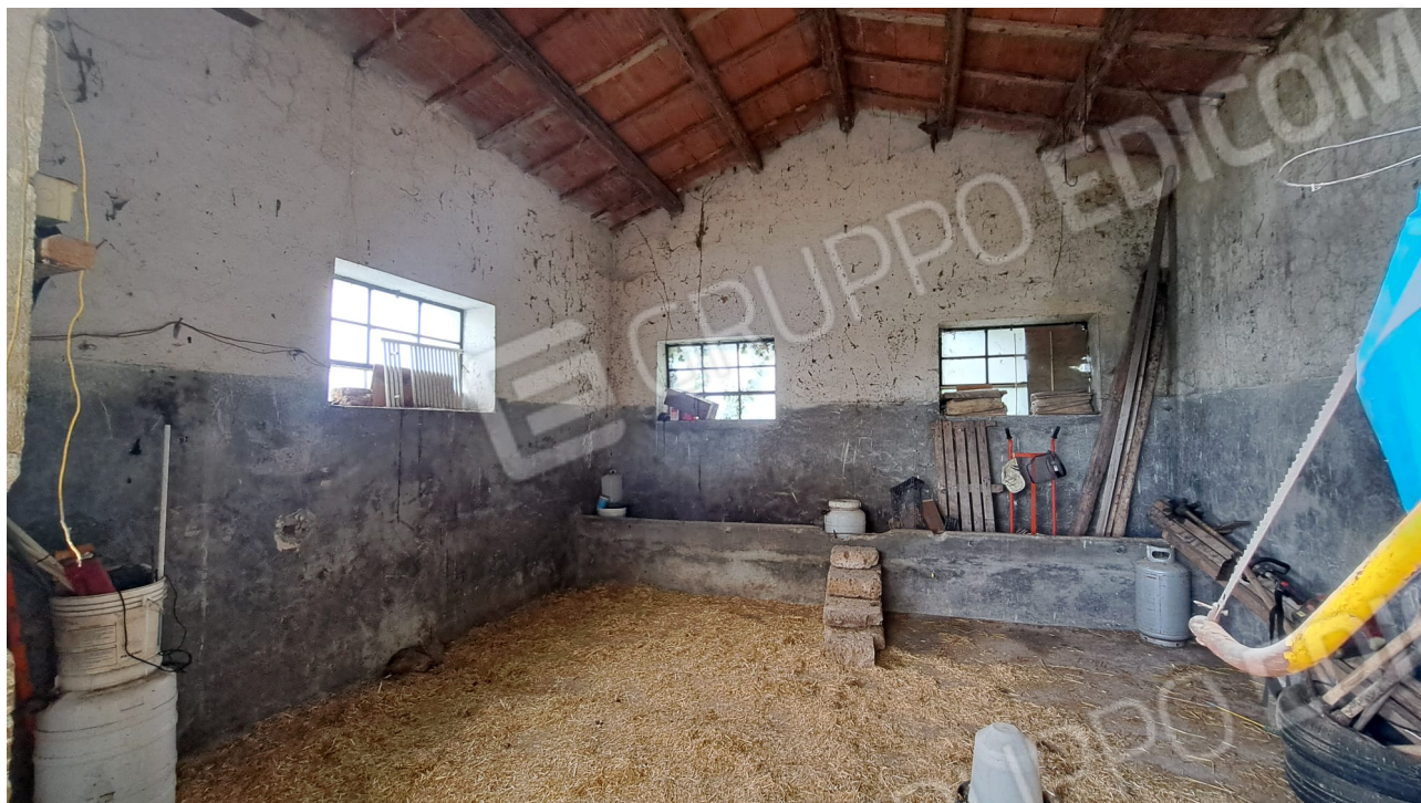
Veduta interna del fabbricato al piano S1 ad uso magazzino (subalterno 9)
