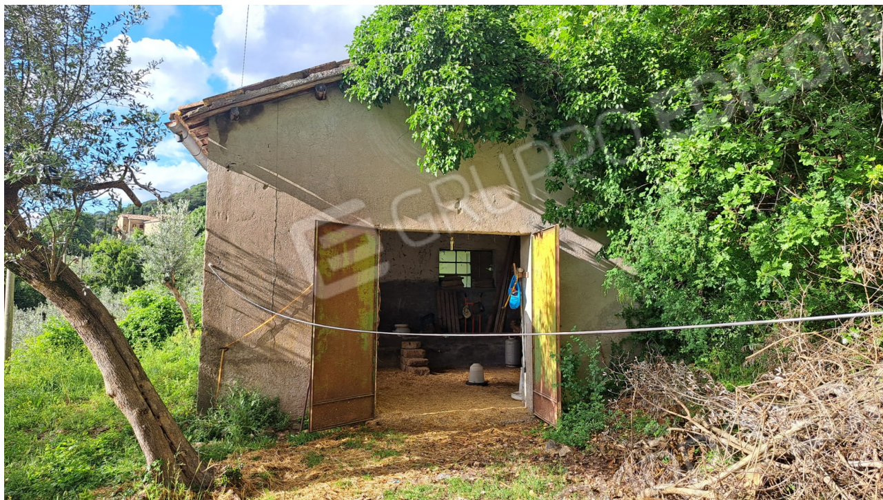
Veduta del fabbricato al piano S1 ad uso magazzino (subalterno 9)
