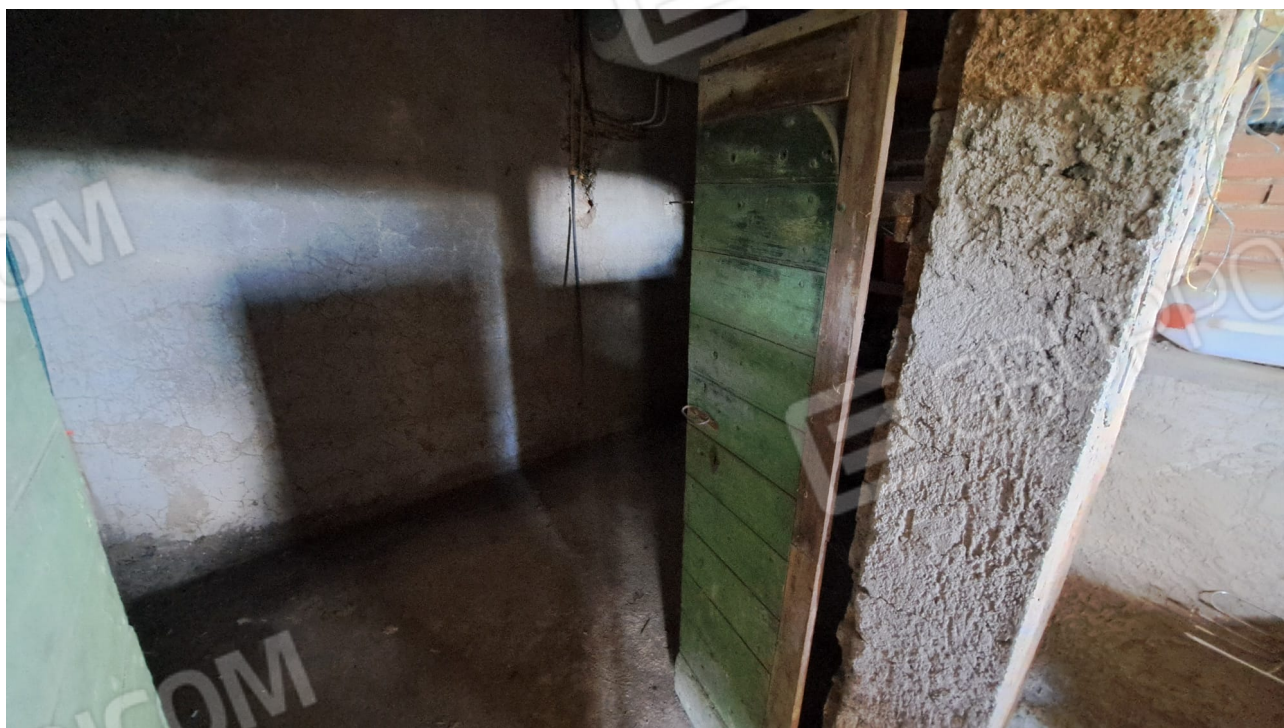
Veduta interna delle cantine al piano S1
