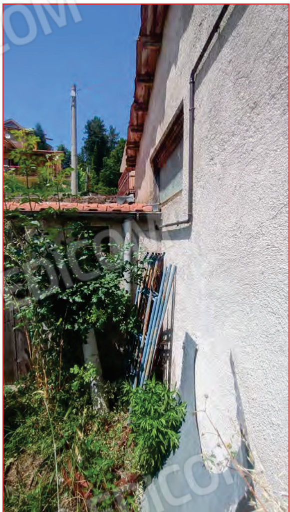
Foto 7 - Cantina esterna piano terra
