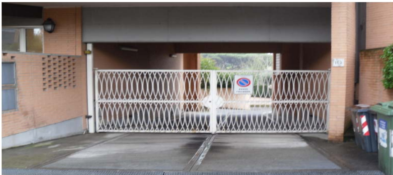
(RAMPA DI ACCESSO AI BOX AUTO – PIANO S2 – CIVICO 10 DI VIA DELLA FOTOGRAFIA)
