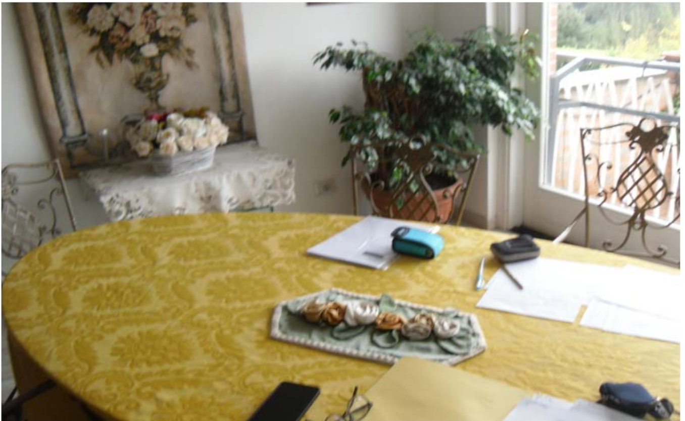
(FOTO INTERNA – ZONA SOGGIORNO – AMPLIAMENTO SU BALCONE - NON CONDONATO)
