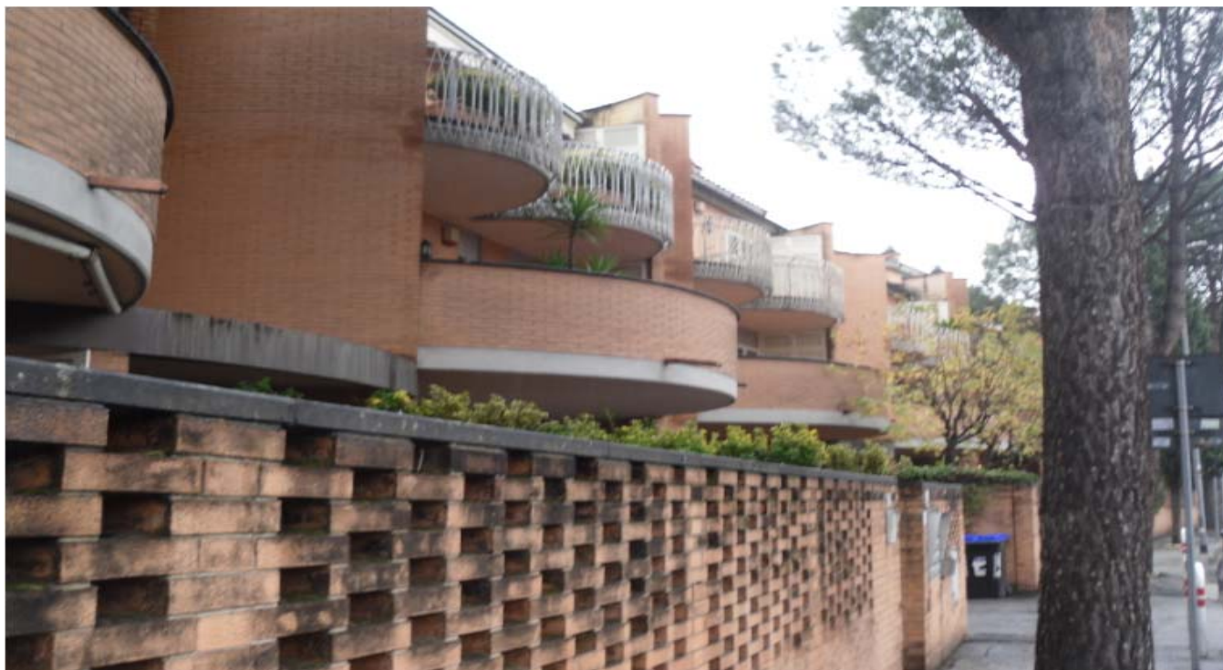
(FOTO ESTERNA DELL'EDIFICIO DI CUI LE PORZIONI IMMOBILIARI IN ESAME SONO PARTE)
