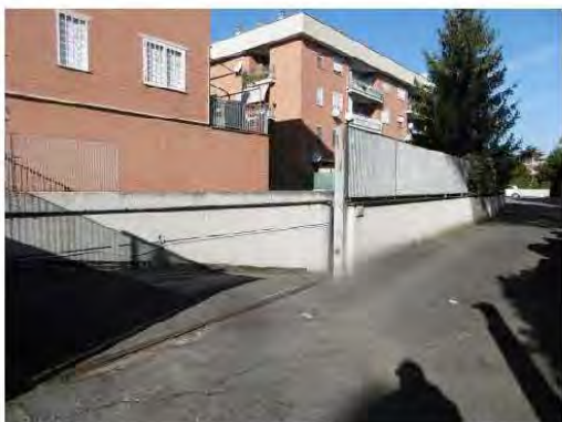
Ingresso all'area recintata condominiale
